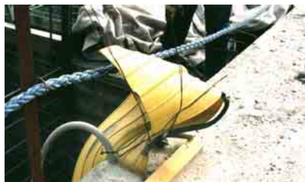
Zalanie "kieszoni" wokół taśmy iniektem elastycznym
