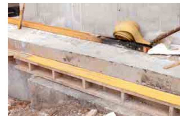
Połączenie resztek z nowym "skrzydełkiem" taśmy przez zgrzewanie
