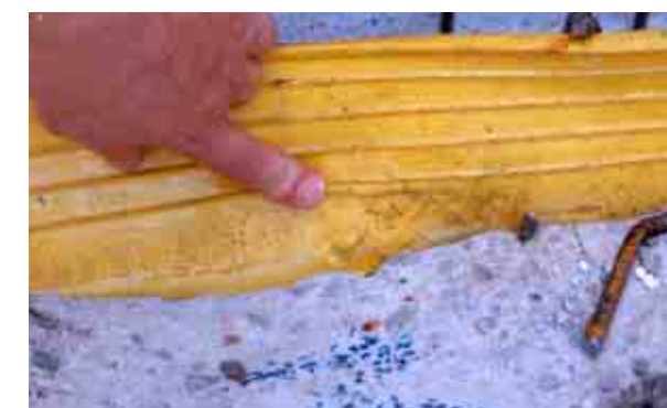
Zatopienie perforacji od przodu i nagrzanie łatki z PCW od tyłu
