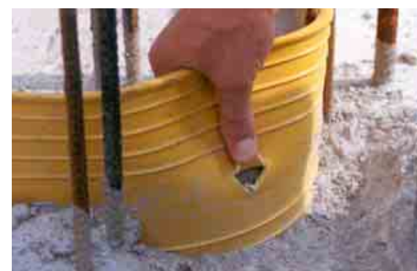
Uszkodzenie taśmy
