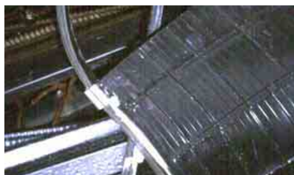
Zamocowanie węży Injectoflex na taśmie Waterbar
