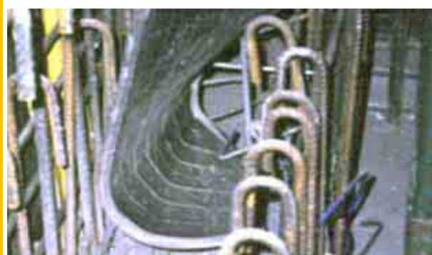
Instalacja układu taśma-wąż iniekcyjny na budowie
