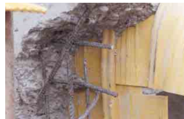
Błąd wykonawczy - przemieszczenie szczeliny dylatacyjnej
