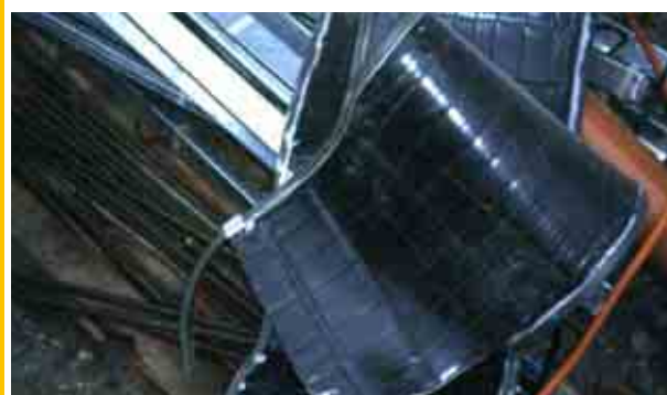
Kombinacja taśma-system Sika Injectoflex umożliwia iniekcję wtórną w przypadku wystąpienia osiadań
