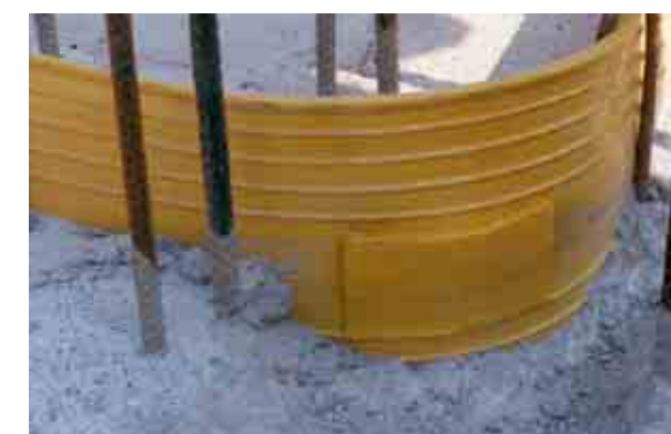
Zatopienie perforacji od tyłu i nagrzanie łatki z PCW od przodu
