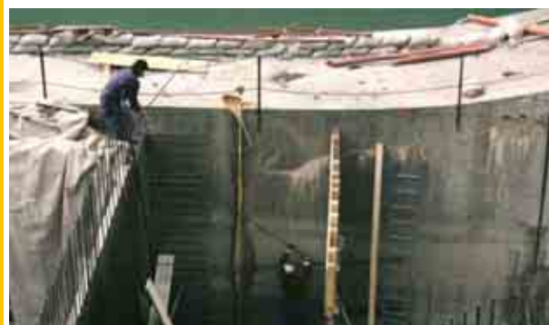
Dwustronne uszczelnienie fugi profilem pęczniącym
