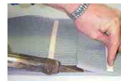
Zgrzewanie dmuchawą "na zakładkę"
