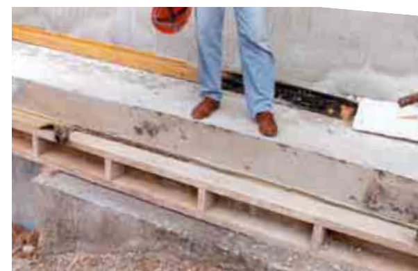
Uszkodzenie odcinka taśmy w wyniku pożaru
