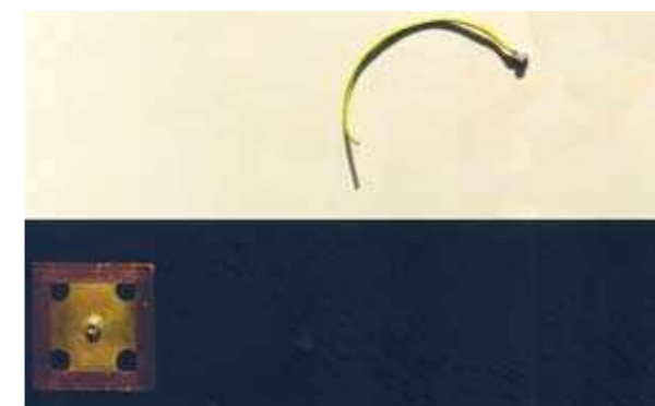
Instalacja uziemienia odprowadzającej ładunki warstwy grafitowej Sikafloor® 220 W Conductive i wierzchniej warstwy przewodzącej Sikafloor® 262 AS, Sikafloor® 381 AS lub Sikafloor® 390 AS.
