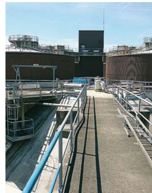
Komory fermentacyjne narażone na korozję siarczanową (kwasy: siarkowy i siarkawy)
