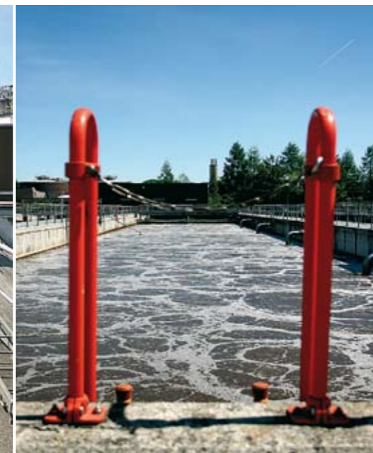
Zbiornik aeracyjny/napowietrzania stopnia biologicznego: obciążenia mechaniczne i chemiczne w strefie powierzchniowej
