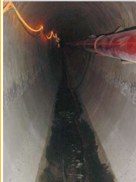
Strefa obciążeń B - częste uszkodzenia betonu
