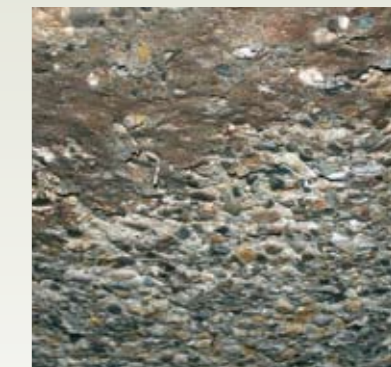
Efekty intensywnej korozji chemicznej betonu w zamkniętej komorze fermentacyjnej (ZKF)
