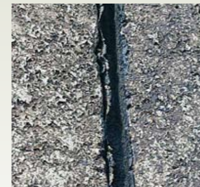
Uszkodzone uszczelnienie dylatacji ściany zbiornika
