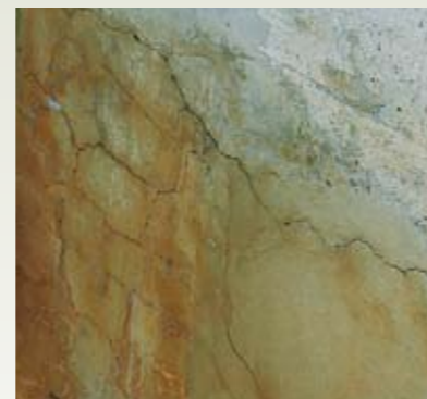
Zarysowania ścian zbiornika
