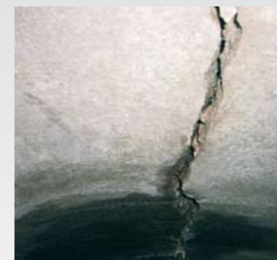
Pęknięcia stanowią poważne zagrożenie dla wód gruntowych
