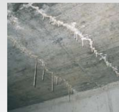
Nieszczelne rysy z naciekami kalcytowymi w wyniku ługowania spoiwa
