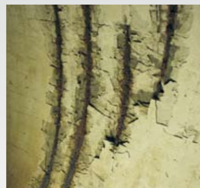
Lokalne, głębokie uszkodzenia betonu ścian
