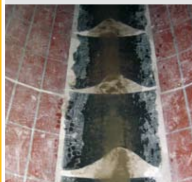
Uszkodzenia abrazyjne strefy dennej kanału
