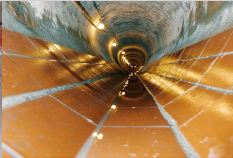
Strefa obciążeń C - przecieki z tej strefy stanowią największe zagrożenie dla wody gruntowej
