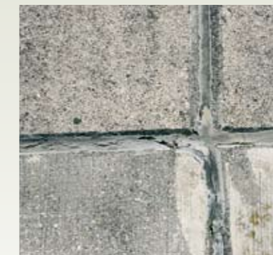
Uszkodzony kit uszczelniający nacięcia przeciwskurczowe płyty dennej
