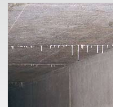
Powierzchnia stropu zabezpieczona przez hydrofobizację przed kondensacją
