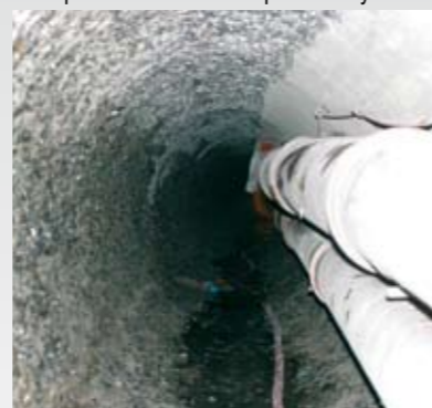
Uszkodzenia wielko-powierzchniowe: widok po hydrodynamicznym przygotowaniu podłoża
