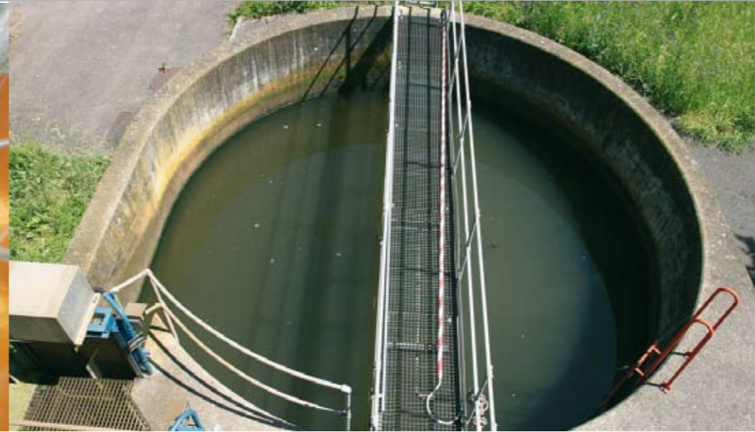
Piaskownik - beton narażony na ścieranie i ługowanie
