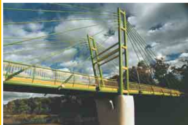
Konstrukcję stalową nowej kładki dla pieszych we Wrocławiu zabezpieczono przed korozją systemem Icosit® EG .
