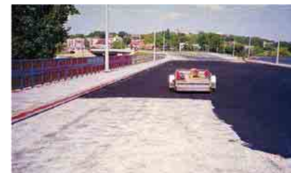
Na moście przez Wartę w Gorzowie Wielkopolskim stalową płytę pomostową zabezpieczono materiałem Icosit® Haftmasse .
