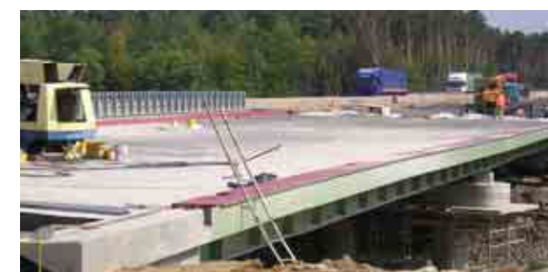
Na moście przez Wartę w Gorzowie Wielkopolskim stalową płytę pomostową zabezpieczono materiałem Icosit® Haftmasse .
