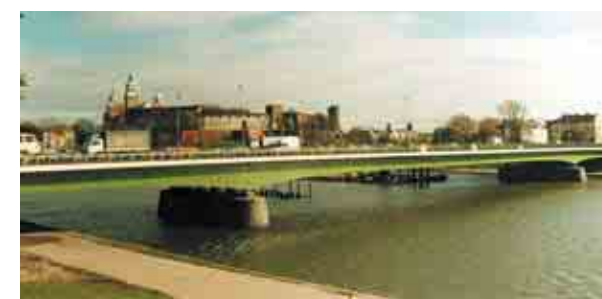
Podczas remontu Mostu Dębnickiego w Krakowie stalową konstrukcję nośną pokryto zestawem Icosit®-Poxicolor® Primer HE , Icosit®-Poxicolor® i Icosit® EG .
