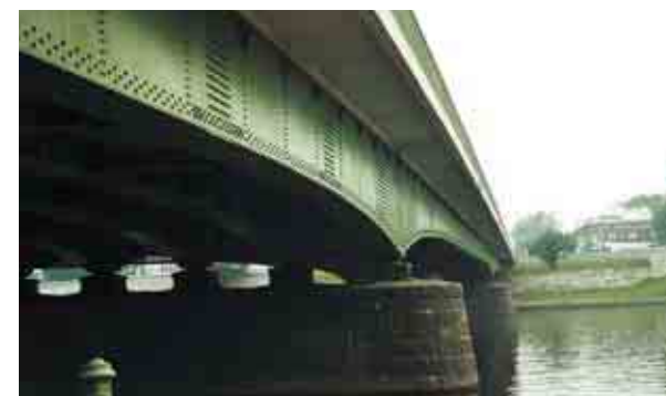
Podczas remontu Mostu Dębnickiego w Krakowie stalową konstrukcję nośną pokryto zestawem Icosit®-Poxicolor® Primer HE , Icosit®-Poxicolor® i Icosit® EG .
