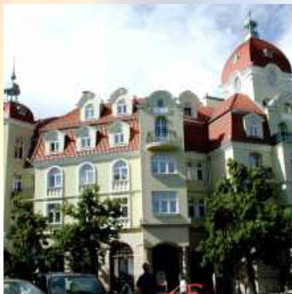
Hotel Rezydent, Sopot; System ociepleń Baumit z tynkiem silikonowym
