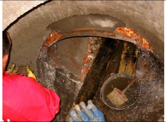
6. Uszczelnienie przecieków
