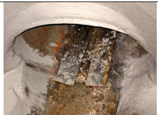
12. Przepiek został usunięty i zabezpieczony
