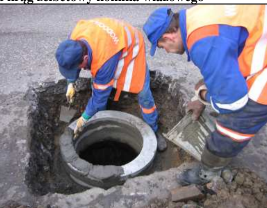
6. Układanie kolejnej warstwy zaprawy szybkosprawnej pod kręgi żelbetowe komina włazowego
