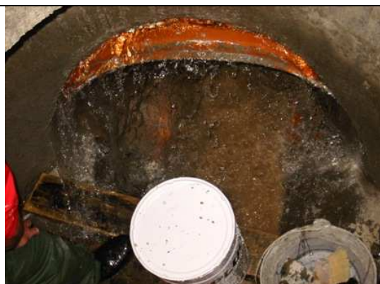
3. Miejsce przecieku oczyszczone i przygotowane do naprawy
