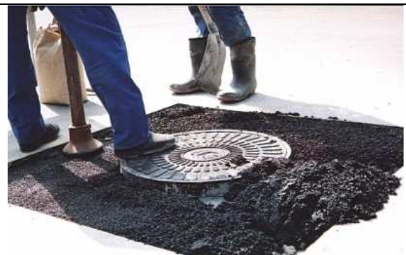
16. Układanie po 1 h masy asfaltowej
