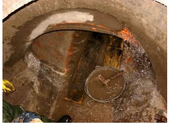
8. Uszczelnienie przecieków
