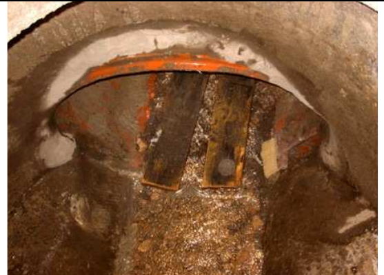
10. Przepiek został całkowicie uszczelniony
