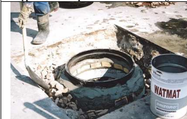
11. Obsypanie wjazdu tłuczniami o frakcji ok. 60mm
