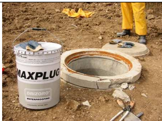
1. Remont studzienki kanalizacyjnej
