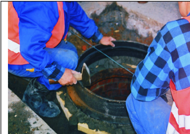
9. Wypoziomowanie pierścienia wjazdu ulicznego
