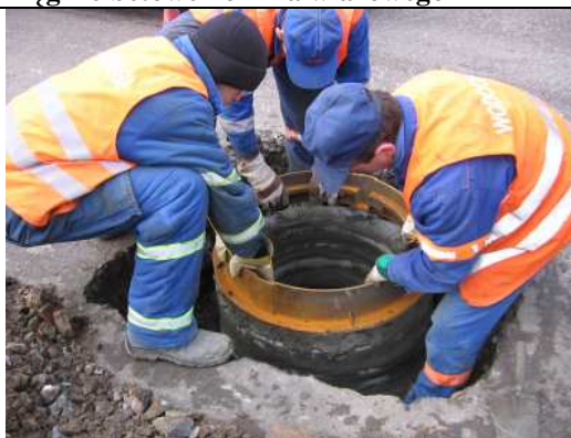
8. Osadzanie pierścienia stalowego włazu ulicznego
