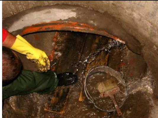
9. Uszczelnienie przecieków
