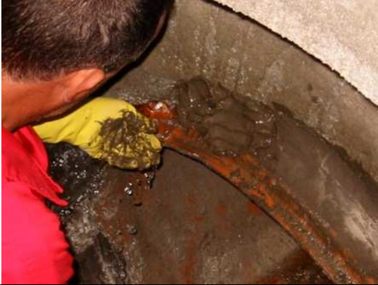
7. Uszczelnienie przecieków
