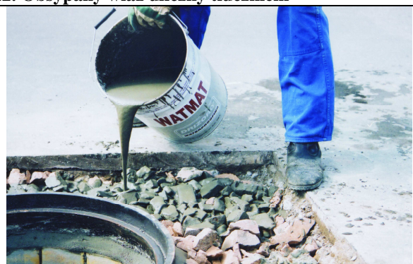
14. Zalanie tłuczni płynną zaprawą szybkosprawną
