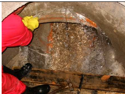
2. Wycieki przy wlocie do studzienki –oczyszczenie powierzchni naprawy
