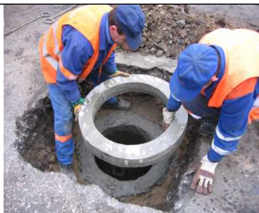
5. Osadzanie kręgu żelbetowego
