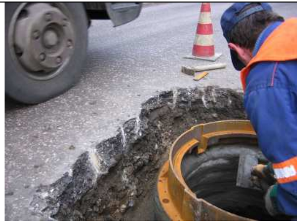
10. Prace wykończeniowe po osadzeniu wjazdu
