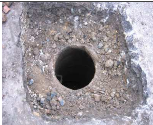
2. Gotowe miejsce naprawy zarwanego włazu
