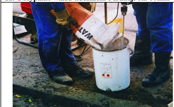
13. Przygotowanie płynnej zaprawy szybkosprawnej
