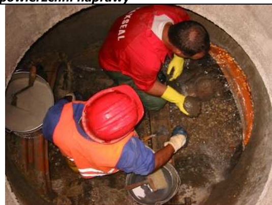
4. Przygotowanie Maxplug do aplikacji
