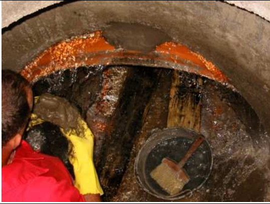
5. Uszczelnienie przecieków
