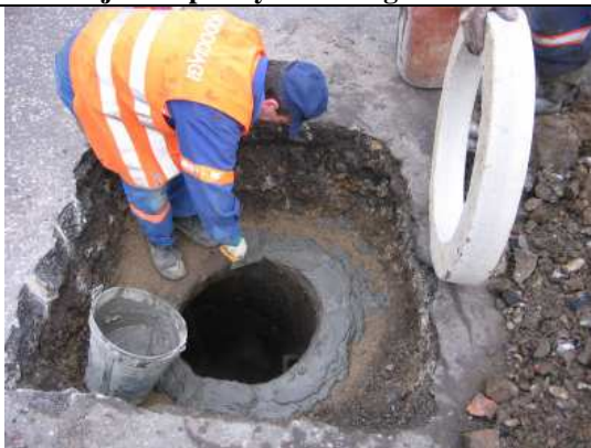
4. Układanie pierwszej warstwy zaprawy szybkosprawnej pod krąg żelbetowy komina włazowego
