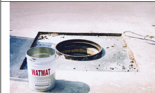
15. Zalany wjazd płynną zaprawą
