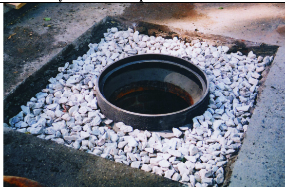
12. Obsypany wjazd uliczny tłuczniami
