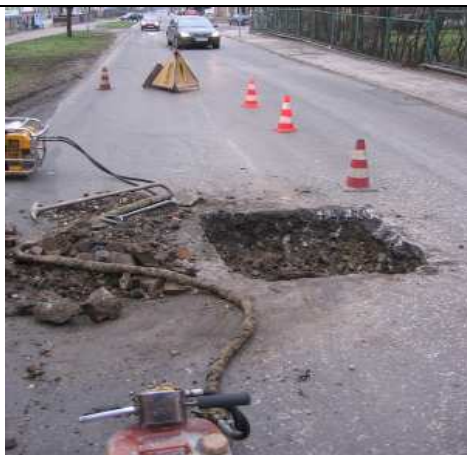
1. Rozkucie nawierzchni wokół włazu kanalizacyjnego
