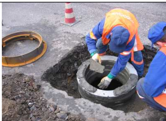
7. Wyrównanie zaprawy szybkosprawnej komina włazowego
