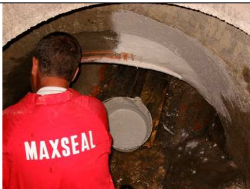
11. Zabezpieczenie powłoką Maxseal Flex
