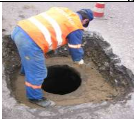
3. Oczyszczenie powierzchni wokół włazu kanalizacyjnego
