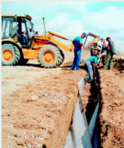
Fot. 1. Rów drenażowy – geowłóknina TYPAR® SF 37. Autostrada A2 w okolicach Poznania.
