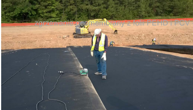
GEOSTAR G5: zgrzewanie na skarpie.
