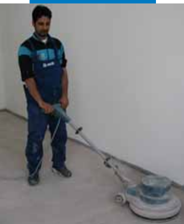
Polerowanie powierzchni szlifierką rotacyjną przed nanoszeniem Ultraplan Eco - Ogródek jordanowski Mirabello - Cantù (Como) - Włochy
