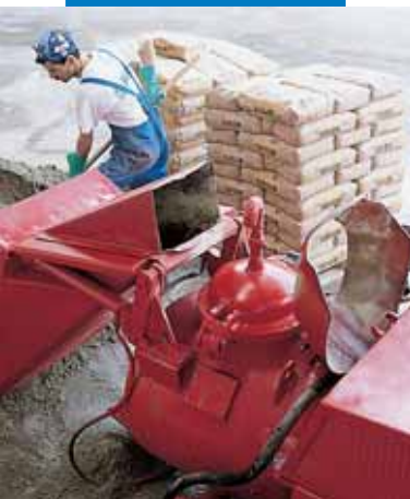
Mieszanie Topcem przy pomocy automatycznej pompy
