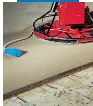
Mechaniczne zacieranie powierzchni podkładu z Topcem
