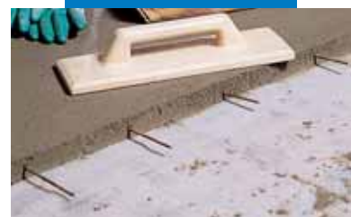
Podkład z Topcem z umieszczonymi w nim prętami zbrojącymi
