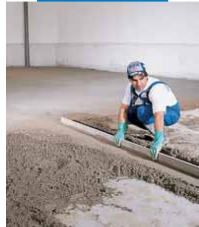
Przygotowywanie pasa poziomującego
