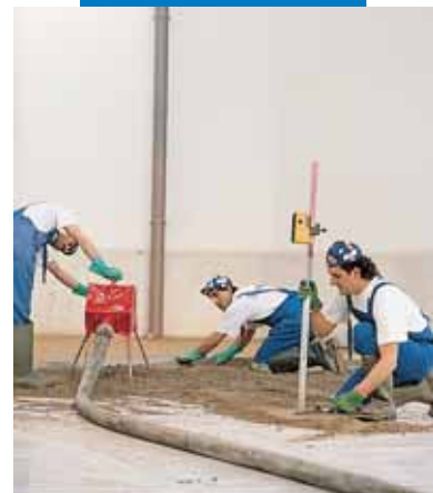
Wyrównywanie podkładu z Topcem
