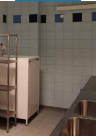
Okładzina ceramiczna położona na powierzchni zagruntowanej Primer S - Szpital w Olomunicu - Republika Czeska
