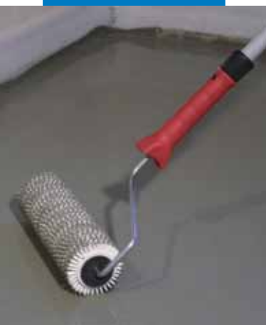
Odpowietrzanie masy Planolit 315 rulonem kolczastym
