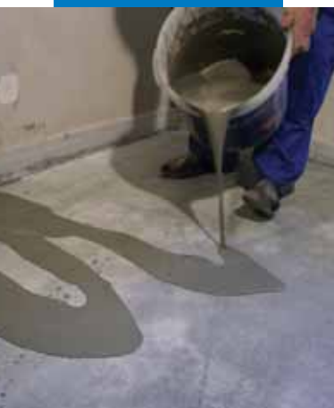
Wylanie masy Planolit 315 na podłoże zagruntowane preparatem Primer G
