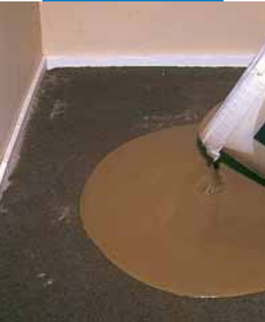
Wylewanie masy Novoplan 21 na podłogę
