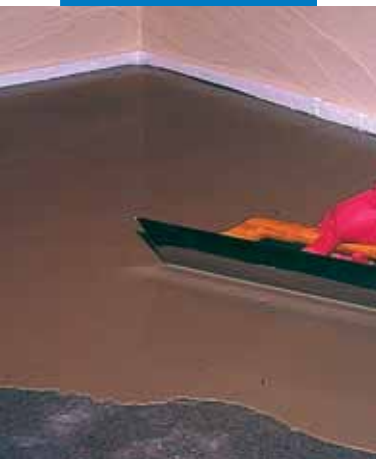
Rozprowadzanie masy Novoplan 21 przy użyciu szpachli metalowej na powierzchni zagruntowanej środkiem Primer G
