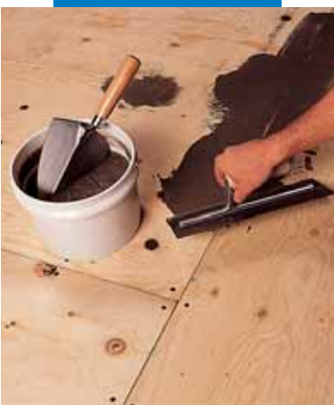
Szpachlowanie podłoża ze sklejk przy użyciu Nivorapid + Latex Plus
