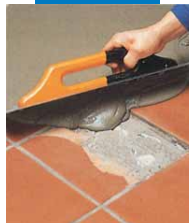
Wypełnianie ubytków przy pomocy Nivorapid
