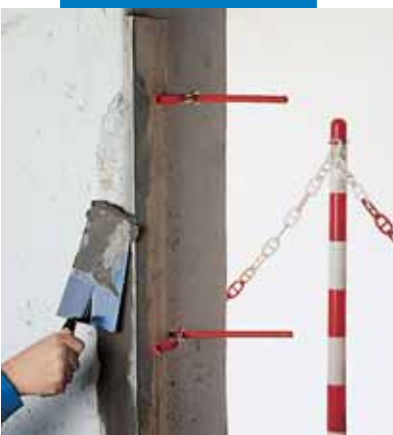
Naprawa pionowego narożnika zaprawą Nivorapid
