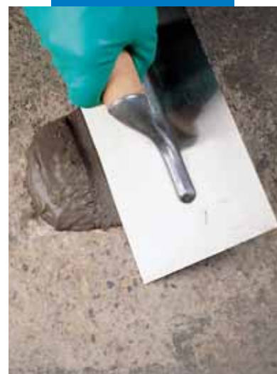
Naprawa poziomych powierzchni przy użyciu Nivorapid
