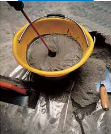
Mieszanie Nivorapid przy pomocy wiertarki z mieszadłem
