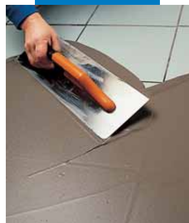
Wyrównywanie istniejącej podłogi przy użyciu Nivorapid
