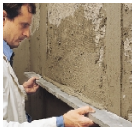
Wyrównywanie powierzchni ścian
