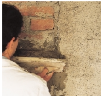
Naprawa istniejących tynków
