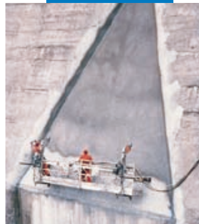
Przykład wykonania natrysku izolacji Mapelastic na zaporze wodnej
