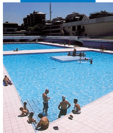
Basen wykonany z zastosowaniem izolacji Mapelastic: Scarioni Leisure Centra - Mediolan, Włochy
