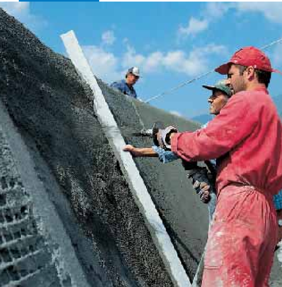
Nanoszenie Mapegrout T40 poprzez natrysk
