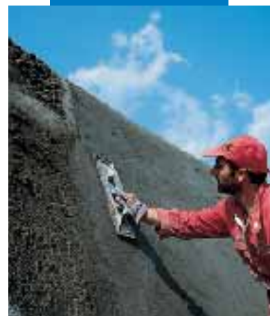
Wyglądanie powierzchni Mapegrout T40
