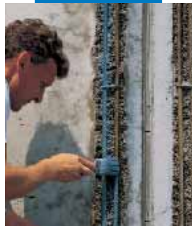
Nanoszenie zaprawy Mapefer
