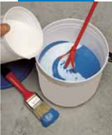
Mieszanie zaprawy Mapefer
