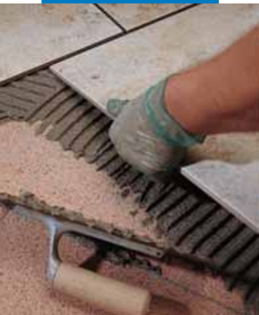
Montaż płytek na istniejące podłoże marmurowe
