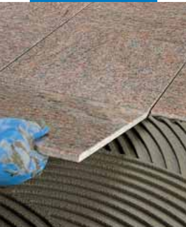
Wykonywanie posadzki z marmuru polerowanego
