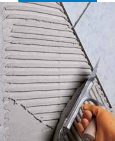
Montaż płytek typu monocottura na powierzchnię z bloczków komórkowych
