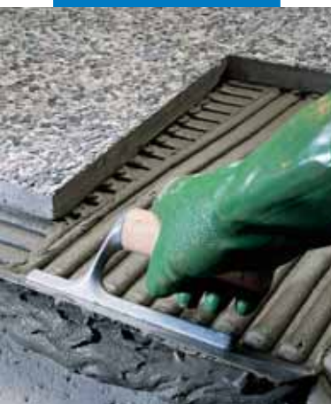
Montaż na zewnątrz budynku płytek "grysowych" (lastryko)
