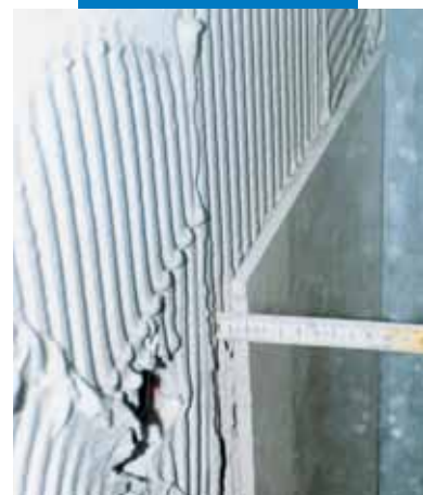
Płytki z gresu szklwionego ułożone na grubej warstwie zaprawy na ścianie
