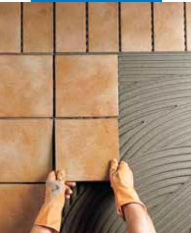
Montaż płytek klinkierowych na zewnątrz
