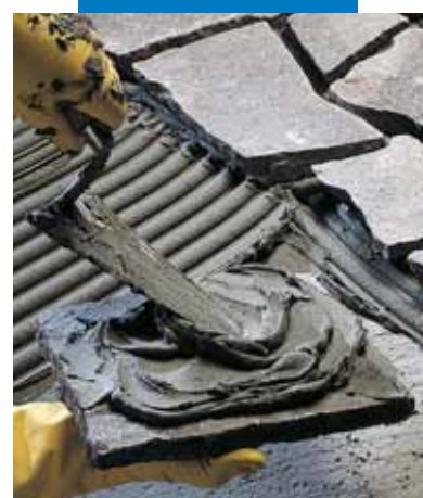
Klejenie na zewnątrz kamieni z obrobioną spodnią stroną, z zastosowaniem lub bez, w zależności od grubości, metody podwójnego smarowania
