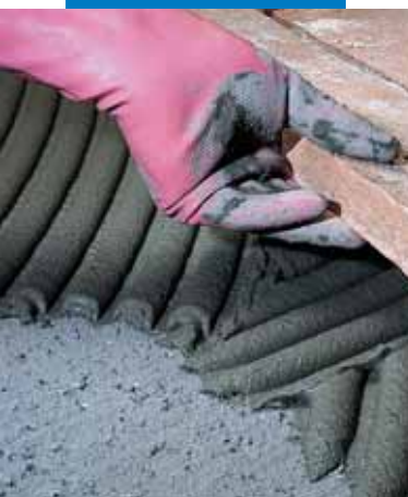
Układanie ręcznie wykonanej terakoty na nierównym podłożu
