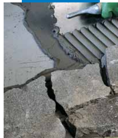
Płytki z gresu szklwionego ułożone na grubej warstwie zaprawy na ścianie
