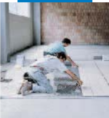
Montaż gresu porcelanowego w zakładach przemysłowych
