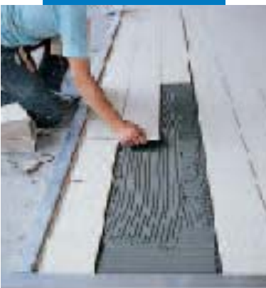
Montaż marmuru typu Jura przy użyciu białej zaprawy klejowej Grasirapid
