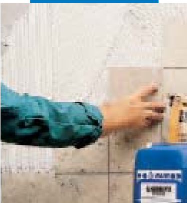
Montaż marmuru typu Jura przy użyciu białej zaprawy klejowej Grasirapid
