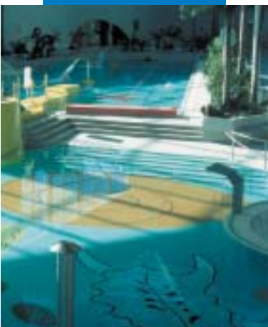
Montaż mozaiki i klinkieru w basenie
