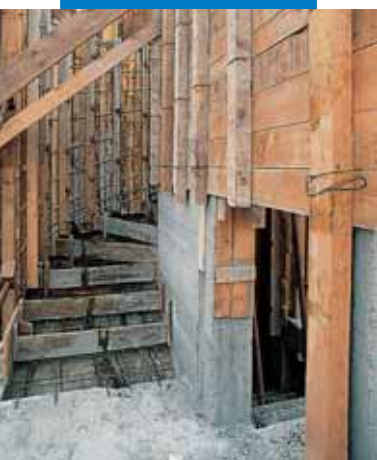
Przykłady deskowania przy użyciu Disarmante DMA 1000
