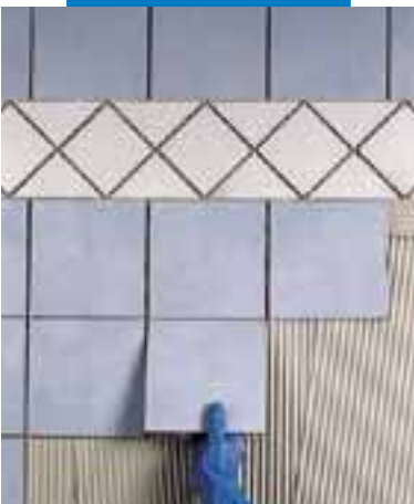
Montaż płytek typu monocotturana na ścianie łazienki (podłozie-tynk)
