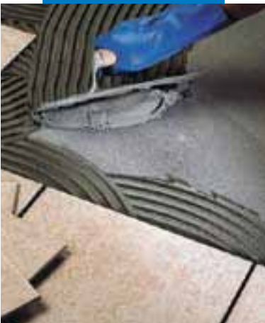
Montaż płytek typu monocotturana podłozie
