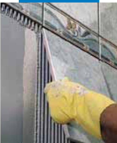
Montaż płytek typu monocotturana na ścianie z płyty kartonowo-gipsowej
