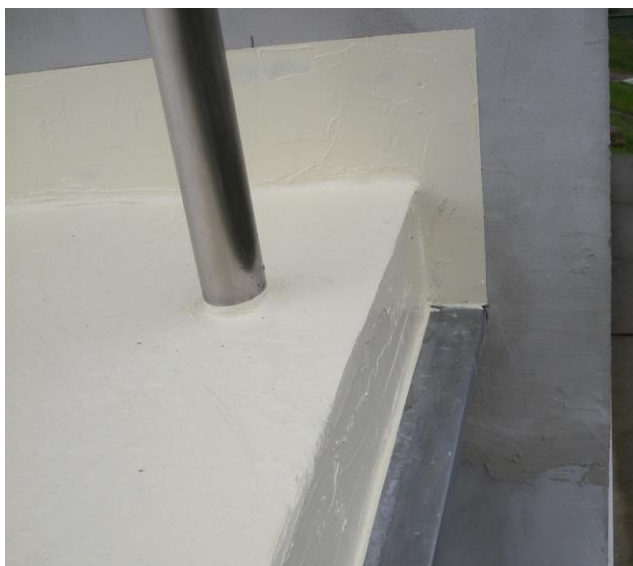
Izolacja na cokole z obróbką blacharską
