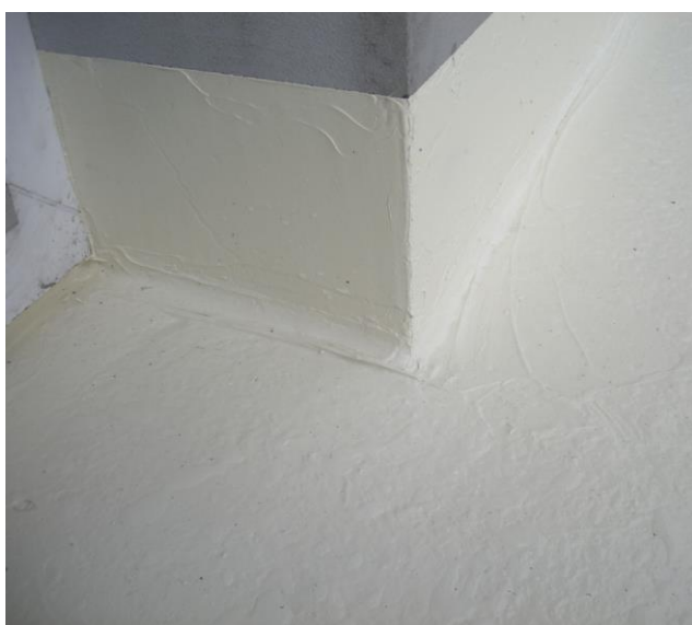
Izolacja na cokole
