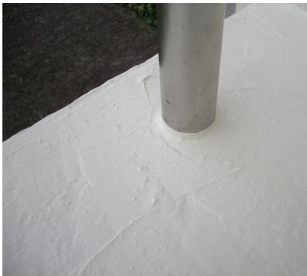
Izolacja na słupku balustrady
