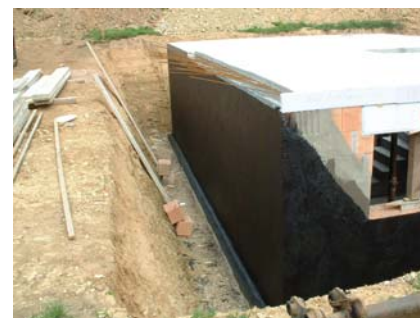
Uszczelnienie zewnętrznej ściany piwnicy z betonu przy zastosowaniu PCI Pecimor ® 2K. Wygodna obróbka dzięki wypełnieniu polistyrenowemu.
