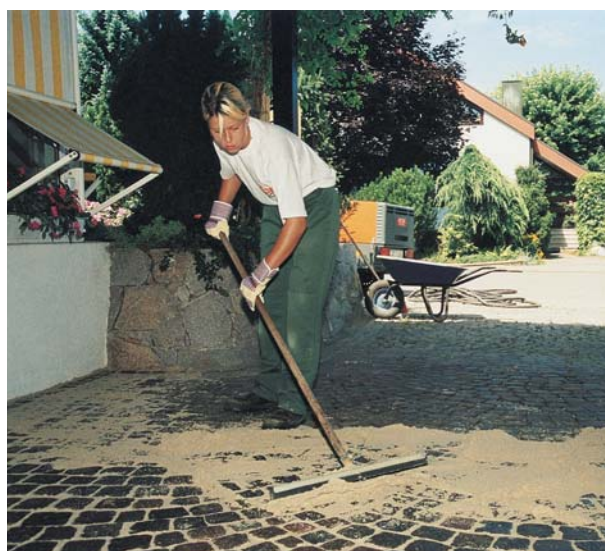
PCI Pavifix 1K daje się za pomocą pacy gumowej łatwo nakładać i zagęszczać oraz pozwala uzyskać równomierny obraz spoin.
