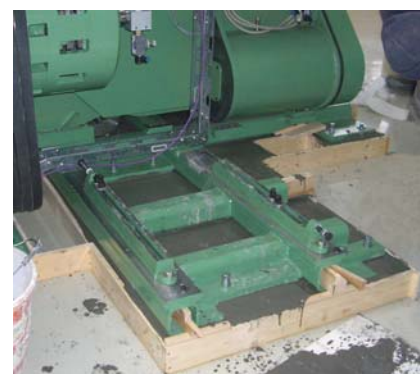
PCI Repaflow ® zapewni przenoszenie obciążeń z pracujących maszyn na fundamenty.
