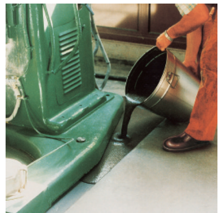
PCI Repaflow® posiada wysoką rozplątność i samoczynnie wypełnia także poziome przestrzenie.
