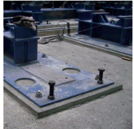
PCI Repaflow® nadaje się do podlewek precyzyjnych, co pozytywnie wpływa na żywotność maszyn.
