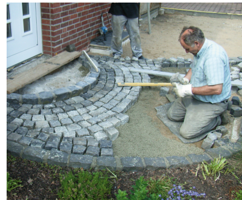
Układanie kostki brukowej na zaprawie PCI Pavifix ® DM
