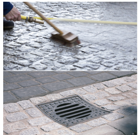
W przypadku metody szlamowania PCI Pavifix ® CEM można łatwo aplikować w spoiny.
