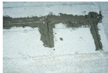
Zabezpieczenie antykorozyjne stali zbrojeniowej za pomocą PCI Nanocret ® AP. W celu zapewnienia całkowitego pokrycia zbrojenia, zaprawę można nanosić także na przylegające podłoże.
