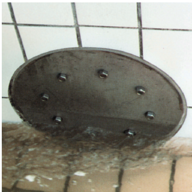
Uszczelnienie przejścia rurowego.
