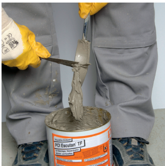
Wstępne czyszczenie mieszadła.
