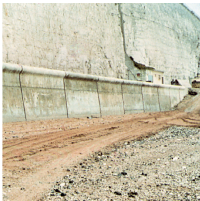
Wypełnienie spoin w murze przeciwpowodziowym.
