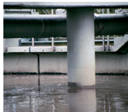
Uszczelnienie dylatacji i spoin łączących w oczyszczalni ścieków.
