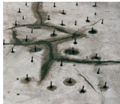
Przyklejanie do podłoża betonowego odspojonych jastrychów cementowych przy użyciu PCI Apogel ® -Schnell.
