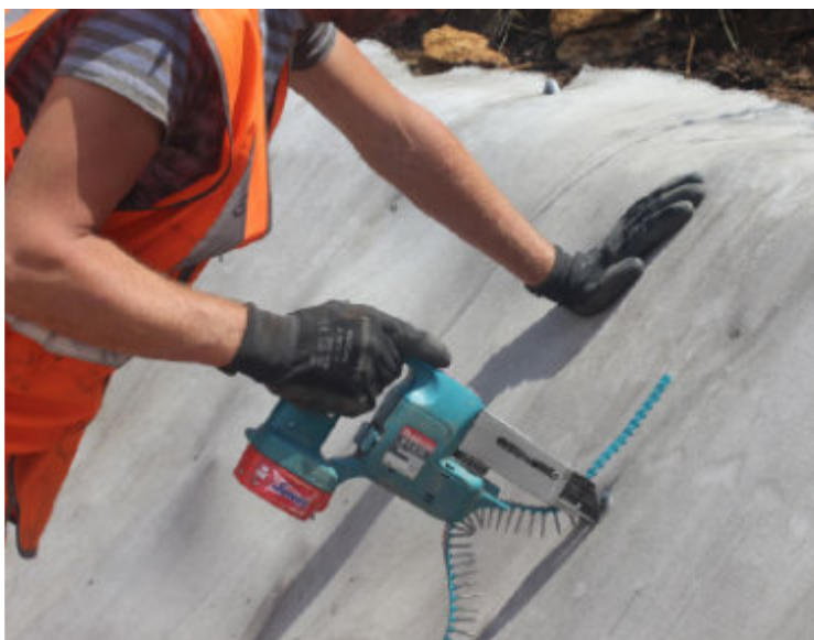
Łączenie CC przy użyciu wkrętaka automatycznego
