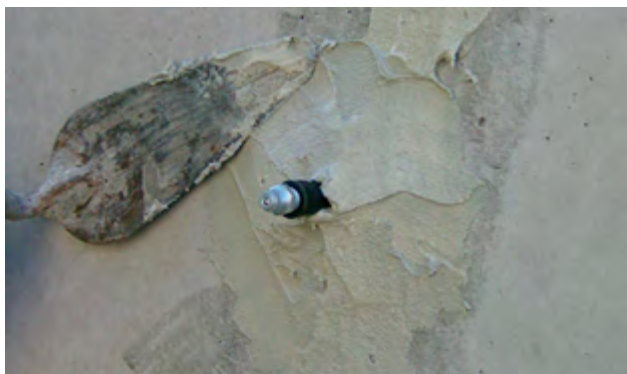
Rys. 2. Uszczelnienie iniektorów naklejanych przy użyciu MasterFlow 920 AN.
