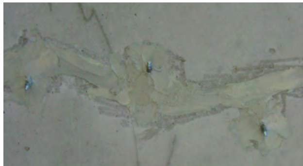
Rys. 1. Iniektory wiercone umieszczone wokół pęknięcia i uszczelnione odpowiednim klejem epoksydowym z serii MasterBrace.
