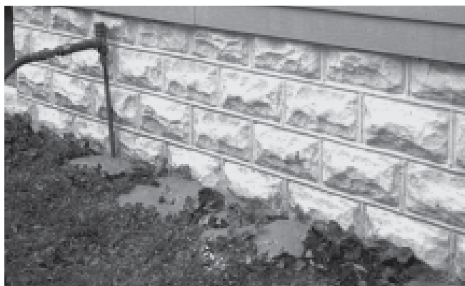
ZASTOSOWANIE PRZY ZEWNĘTRZNYCH ŚCIANACH MUROWANYCH: Wstrzykiwać zaprawę BENTOGROUT® wzdłuż zewnętrznej powierzchni ściany fundamentowej w odstępach do 600 mm
