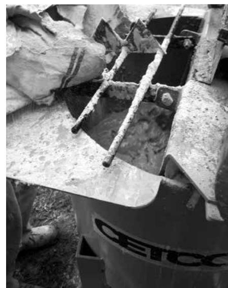
Mieszanie zaprawy BENTOGROUT® mieszadłem firmy CETCO
