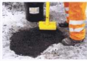
Zagęszczamy ubijakiem ręcznym lub mechanicznym
