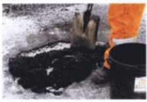
Drugą warstwę masy IRR rozprowadzamy np. łopatą
