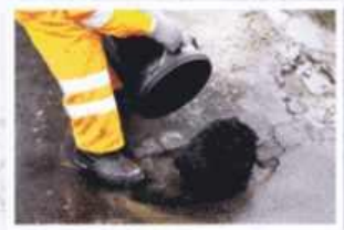
Wypełniamy ubytek prosto z poręcznego opakowania
