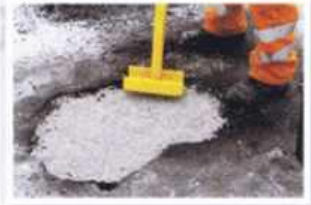
Zagęszczamy kruszywo pozostawiając 2cm na warstwę IRR
