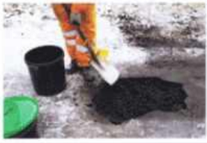
Rozprowadzamy prostym narzędziem tworząc warstwę ok 2cm
