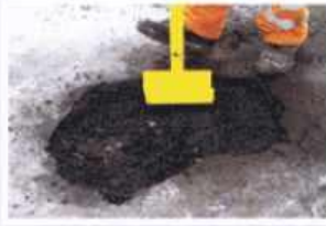
Zagęszczamy ubijakiem ręcznym lub mechanicznym
