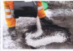
Wypełniamy kruszywem (np z wiadra po IRR )
