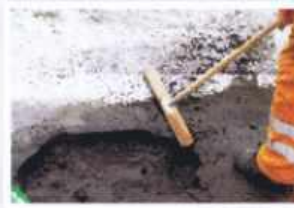
Oczyszczamy ubytek w jezdni
