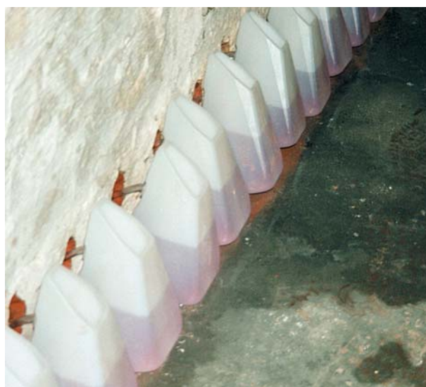
PCI Bohrlochsperr iniekuje się grawitacyjnie przez minimum 24 godziny.
