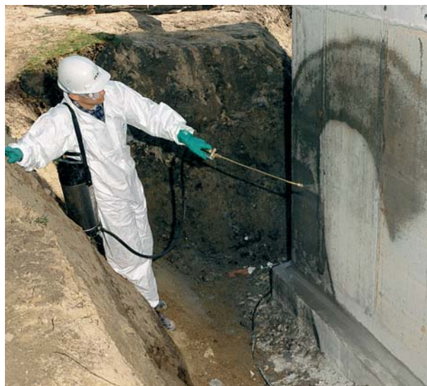
Uniknięcie pęcherzy na grubowarstwowej izolacji bitumicznej po za-gruntowaniu powierzchni betonowych PCI Pecimor®-Betongrund.
