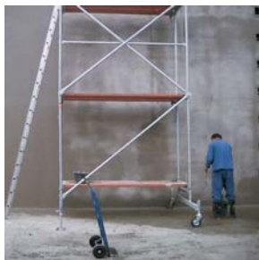
Naprawa ścian zbiornika zwrotnej wody deszczowej – przy użyciu zaprawy PCI-Kanadicht odpornej na działanie siarczanów.
