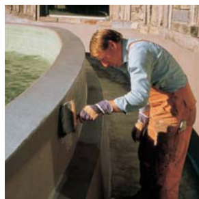
Nanoszenie ręczne - zawiesina PCI-Kanadicht tworzy powłokę o trwałej wodoodporności.
