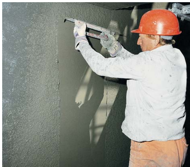
Wodoszczelne pokrywanie powierzchni systemu kanalizacyjno-ściekowego zawiesziną uszczelniającą PCI-Kanadicht, odporną na działanie siarczanów.
