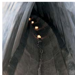
Zawiesina PCI-Kanadicht chroni powierzchnię przed uszkodzeniami spowodowanymi korozją, przedłużając trwałość budowli kanalizacyjnych.
