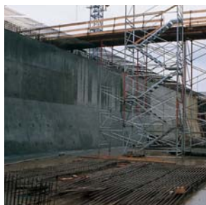
Odporna na działanie siarczanów zawiesina uszczelniająca PCI-Kanadicht zapewnia trwałą ochronę powierzchni nowo wykonanych budowli kanalizacyjnych.
