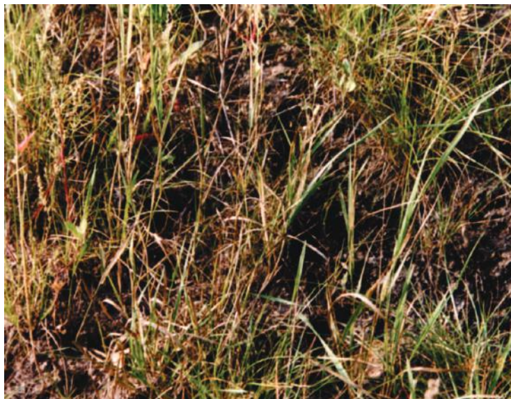
Rys. 10. Roślinność porastająca skarpe północną budowli 1 (fot. B. Gajewska)
