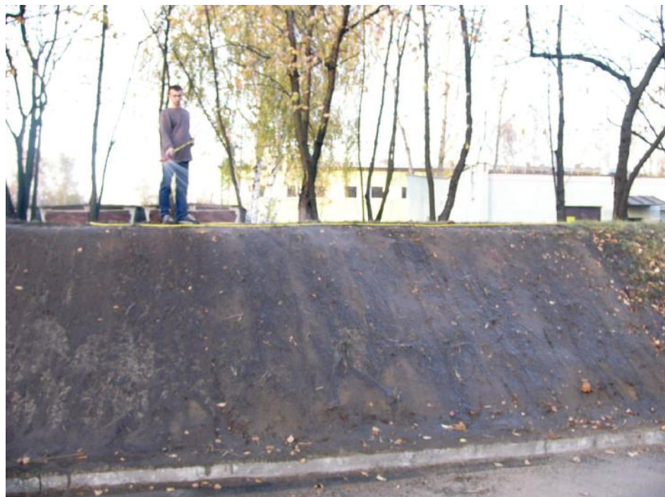
Rys. 44. Wałowanie i obfite zraszanie powierzchni skarpy (fot. B. Gajewska)
