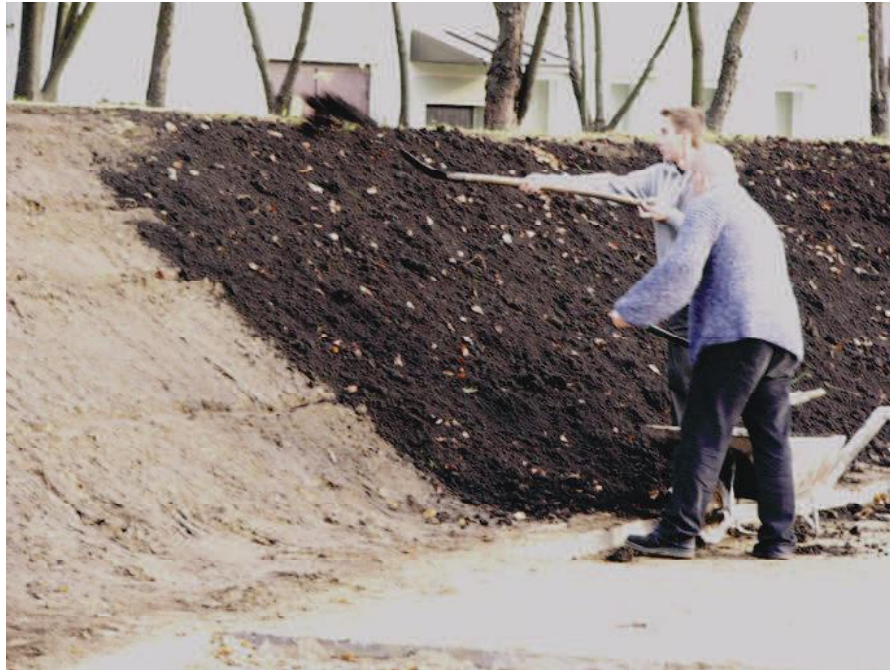
Rys. 46. Układanie humusu na skarpie (fot. B. Gajewska)
