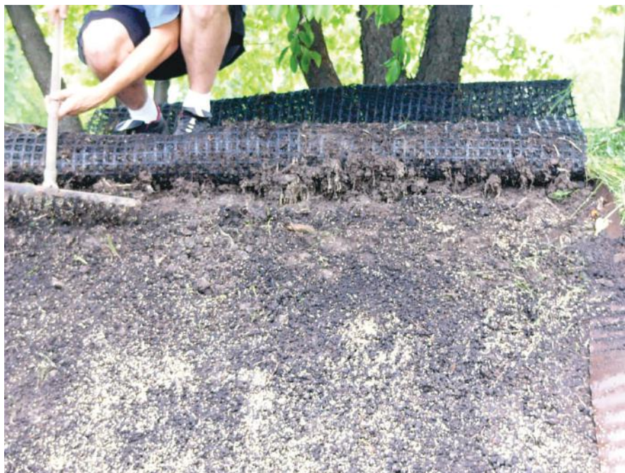
Rys. 70. Zagrabianie powierzchni skarpy (fot. B. Gajewska)
