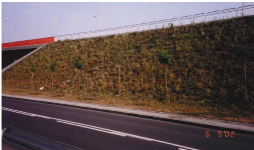
Rys. 7. Widok skarpy południowej budowli 1 (fot. B. Gajewska)
