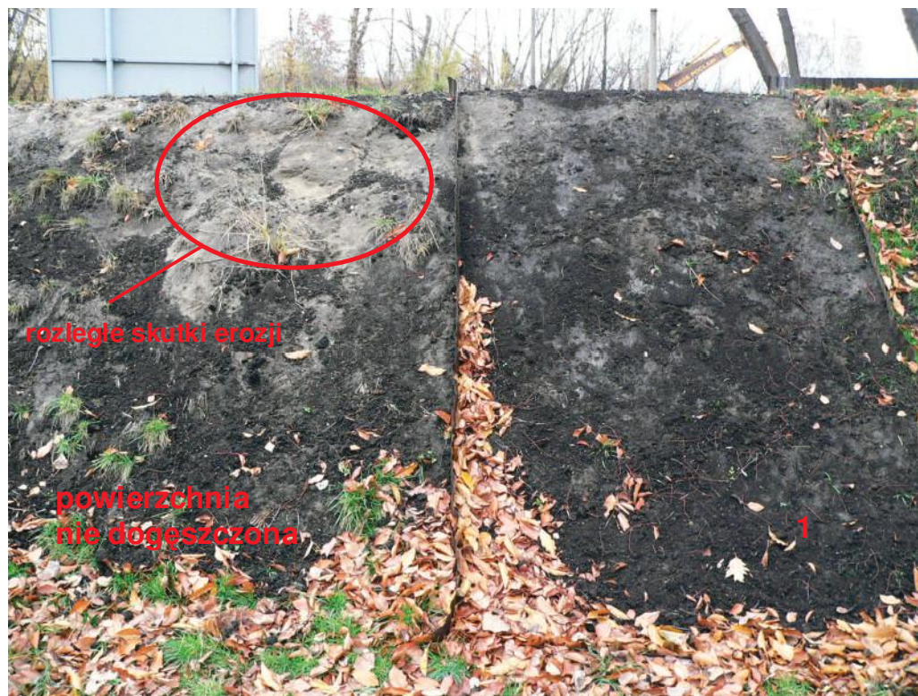
Rys. 91. Porównanie erozji powierzchni dogoszczonej i nie dogoszczonej (Fot. B. Gajewska)
