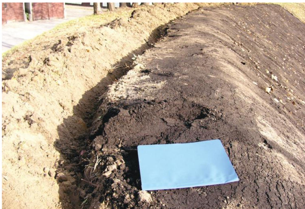
Rys. 48. Rowek kotwiący na szczycie skarpy (fot. B. Gajewska)
