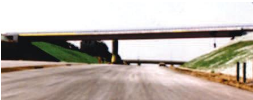
Rys. 15. Widok skarp budowli 3 zabezpieczanych przed erozją powierzchniową z użyciem geosiatek SLOVARM (fot. B. Gajewska)
