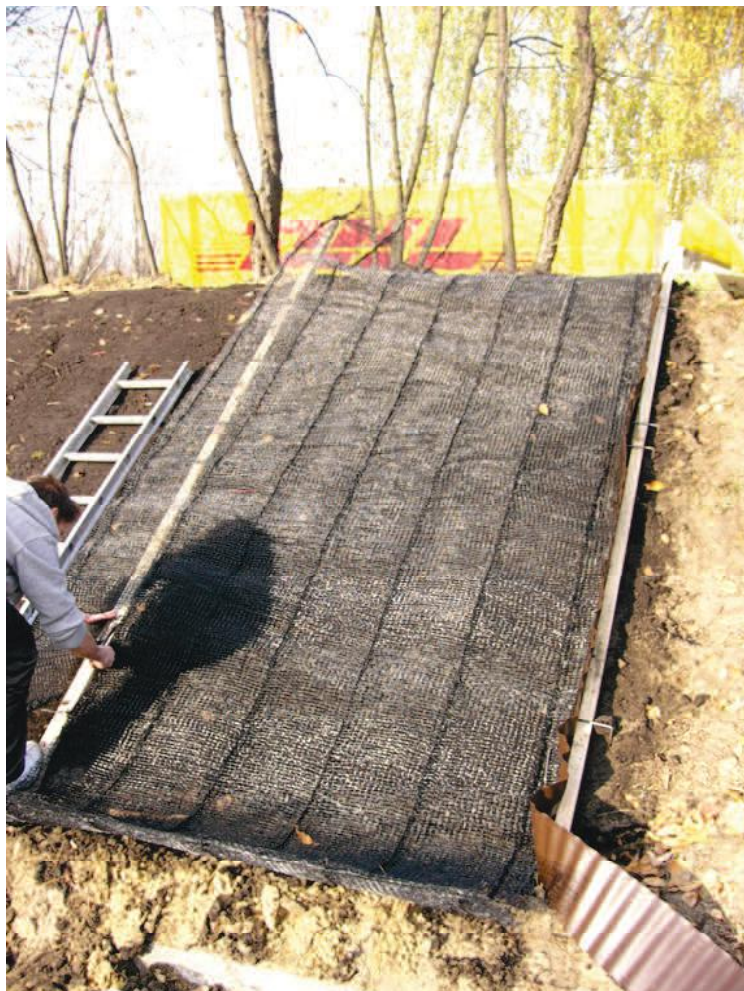
Rys. 50. Pasma geosyntetyku docinano do rozmiarów poletka (fot. B. Gajewska)
