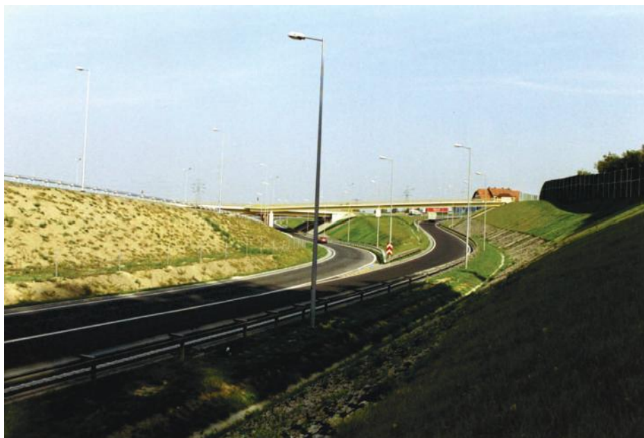
Rys. 20. Skarpy budowli 3 w rok po wykonaniu umocnień przeciwoerozyjnych z zastosowaniem geosyntetyków (fot. B. Gajewska)
