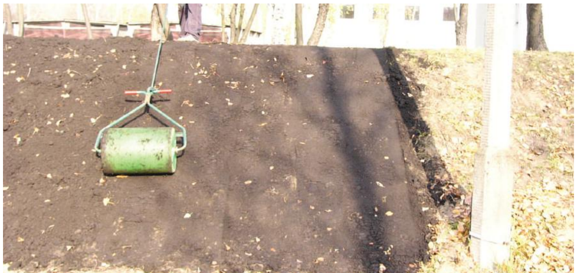
Rys. 47. Ułożoną na skarpie warstwę humusu dogęszczano za pomocą walca (fot. B. Gajewska)
