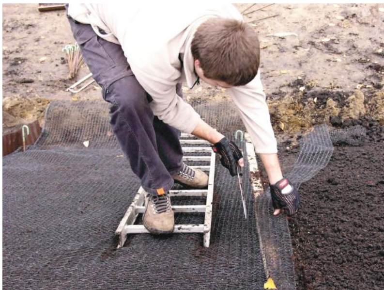
Rys. 54. Wszystkie czynności wykonywane na skarpie odbywały się z drabiny (fot. B. Gajewska)
