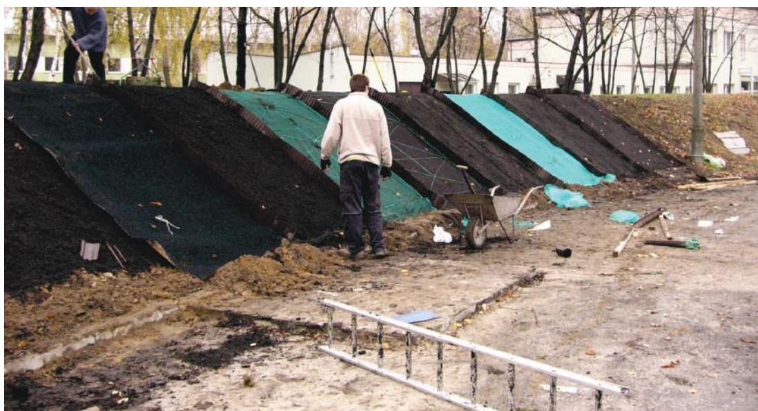
Rys. 56. Wypełnianie geomaty humusem (fot. B. Gajewska)
