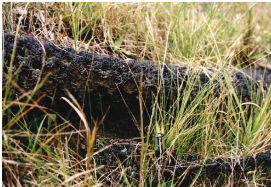
Rys. 22. Fragment skarpy ze sfalowaną geomatą VHVD (fot. B. Gajewska)
