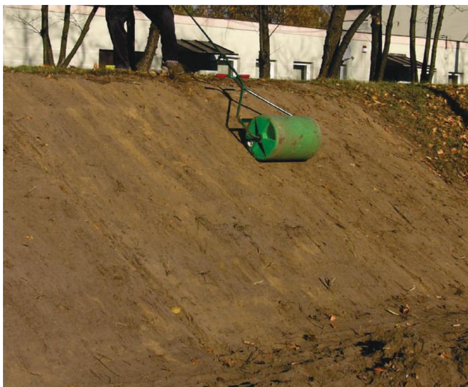
Rys. 43. Wałowanie powierzchni skarpy po wyprofilowaniu (fot. B. Gajewska)
