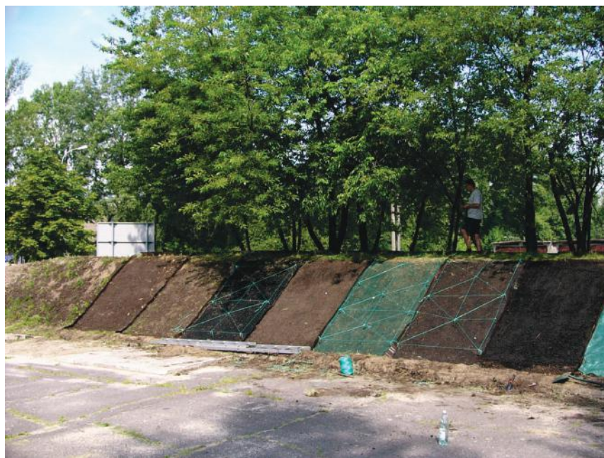
Rys. 71. Widok poletek tuż przed zakończeniem robót (fot. B. Gajewska)
