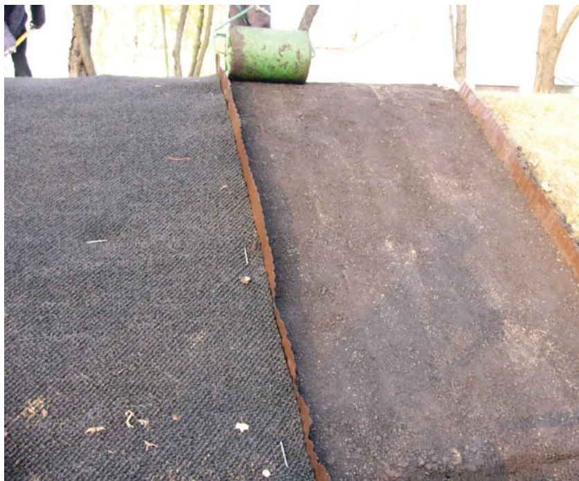
Rys. 53. Wałowanie wypełnionej humusem i obsianej nasionami traw maty (fot. B. Gajewska)
