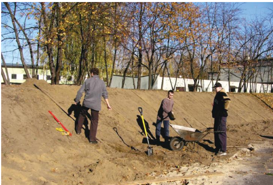
Rys. 42. Formowanie skarpy (fot. B. Gajewska)
