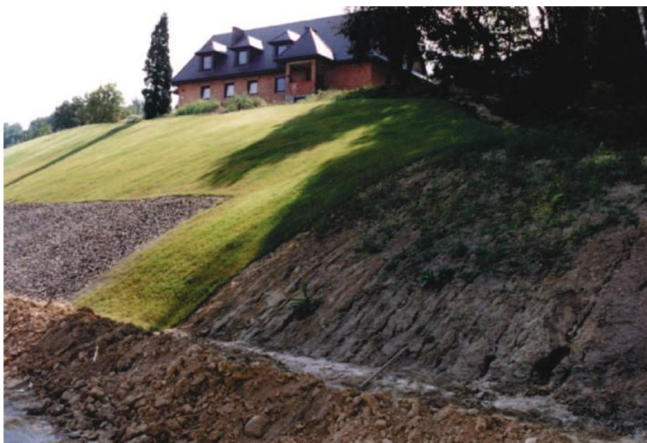
Rys. 16. Fragment skarpy północno wschodniej budowli 3. Od lewej widoczna jest powierzchnia skarpy zabezpieczona przed erozją, bliżej – bez zabezpieczeń (fot. B. Gajewska)
