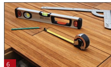
6 Przycięcie desek na odpowiednią długość, a następnie przymocowanie do konstrukcji nośnej.
