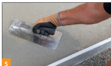
5 Wykonanie warstwy jastrychu z BOTAMENT® M 54 FM lub M 56 Speed FM.
