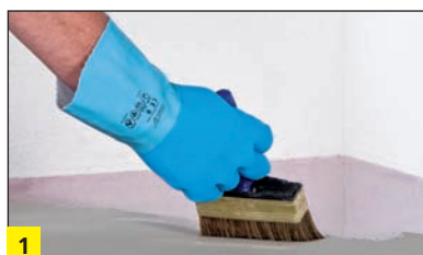
1 Gruntowanie podłoża przy zastosowaniu BOTAMENT® D 11.
