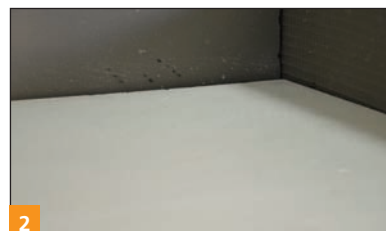
2 Przyklejenie termoizolacji.
