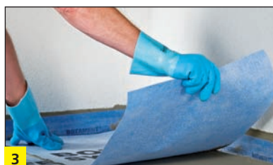
3 Klejenie maty uszczelniająco – kompensującej BOTAMENT® AE przy użyciu elastycznej zaprawy klejowej BOTAMENT® M 21 lub szybkowiążącej zaprawy klejowej BOTAMENT® M 10 Speed, z zachowaniem 5 cm zakładu.
