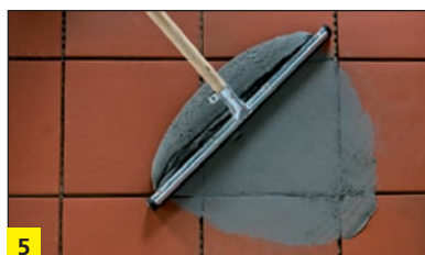
5 Spoinowanie okładziny przy zastosowaniu MULTIFUGE® Base.
