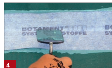
4 Wtąpienie systemowej taśmy uszczelniającej w pierwszą warstwę izolacji.
