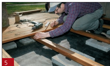
5 Przygotowanie konstrukcji nośnej.
