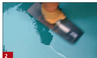
2 Naniesienie powłoki izolacyjnej w dwóch cyklach roboczych.
