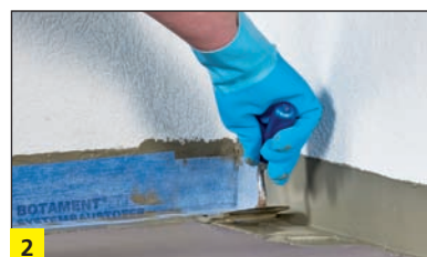
2 Wklejanie taśmy uszczelniającej BOTAMENT® SB 78 w narożnikach wewnętrznych, w warstwę zaprawy klejowej BOTAMENT® M 21 lub BOTAMENT® M 10 Speed.
