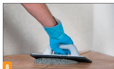
8 Spoinowanie okładziny przy zastosowaniu MULTIFUGE® Base.
