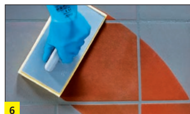
6 Mycie zaspoinowanej powierzchni.
