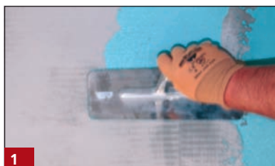
1 Wykonanie szpachlowania drapanego z BOTAMENT® RD 2 THE GREEN 1 .
