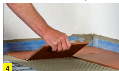
4 Klejenie płytek ceramicznych metodą kombinowaną na zaprawie klejowej MULTISTONE®, MULTILIGHT, BOTAMENT® 29/29HP.
