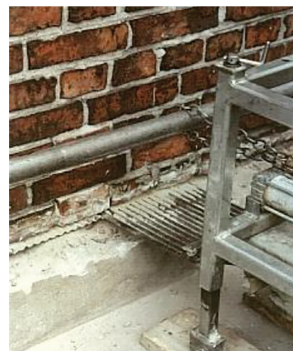
Rys. 3. Wbijanie blachy w spoinę za pomocą młota pneumatycznego [3]
