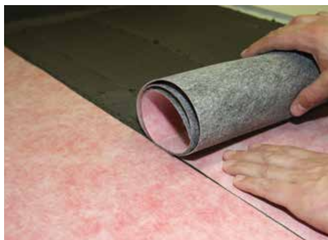
6 Układanie mat Sopro AEB® 639 plus na styk.
