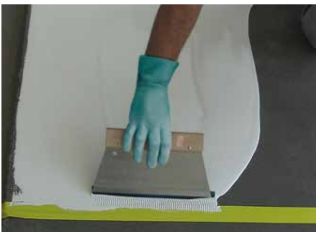
5 Nanoszenie elastycznej powłoki uszczelniającej Sopro PU-FD 571 na podłogę w dwóch warstwach o łącznej grubości min. 1 mm.
