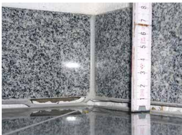
Odształcenia jastrychu, powstałe w wyniku nieprzestrzegania niektórych wymogów prowadzą do nadmiernego rozciągnięcia i oderwania fugi silikonowej.
