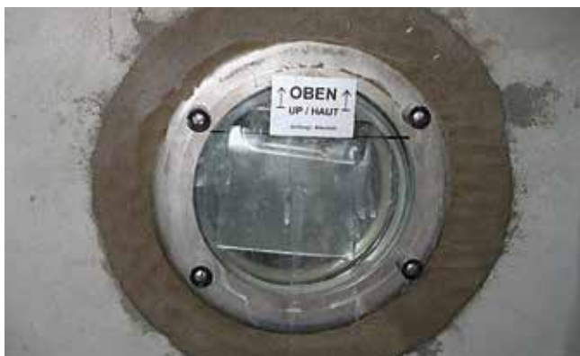
Obudowa reflektora zaszpachlowana antykapilarnie przy użyciu Sopro DBE 500.
