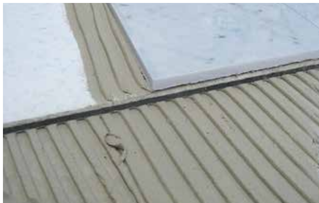
Płyty Sopro FDP 558 ułożone na podeście schodów jako wygłuszenie pod okładziną z kamienia naturalnego.
