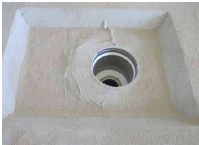
Uszczelnione i uszorstnione piaskiem kwarcowym zagłębienie pod odwodnienie ze stali nierdzewnej. Widoczne są sfazowane krawędzie jastrychu.
