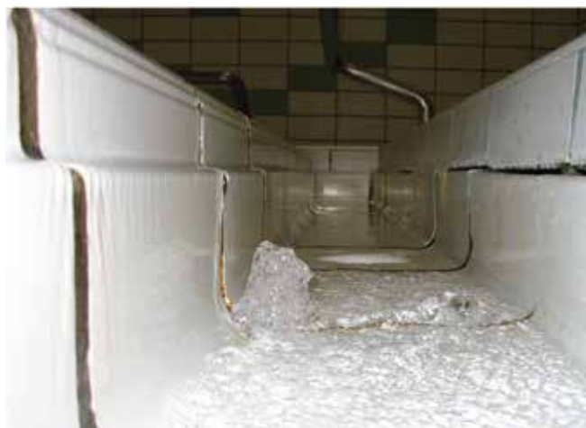
Porowata zaprawa fugowa; woda pod działaniem ciśnienia znajduje ujście przez dno rynny przelewowej.
