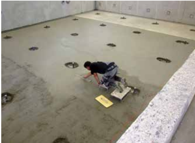
Wykonanie jastrychu zespolonego o możliwości szybkiego użytkowania np. z zastosowaniem Sopro Rapidur B5 (jako mostek szczepny użyty Sopro EPG 522 ).
