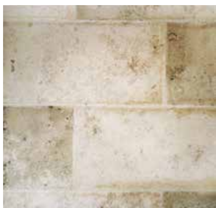
Przebarwienia krawędzi i zmiany odcienia w obrębie płyty, spowodowane wysoką zawartością wody w zaprawie grubowarstwowej.
