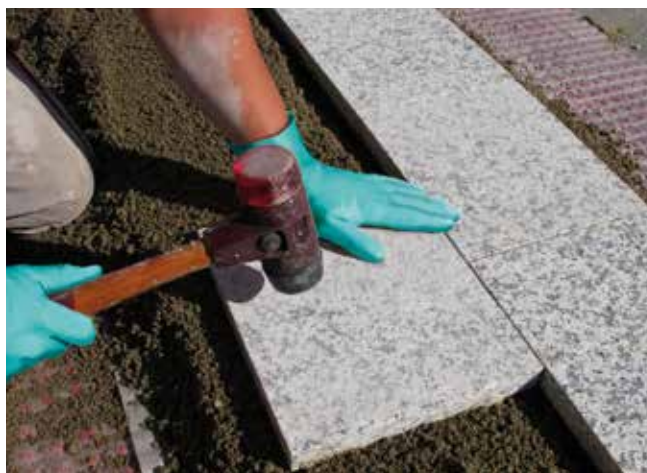
4 Ułożenie płyty kamiennej na warstwie drenażowej zaprawy grubowarstwowej, dociśnięcie gumowym młotkiem.
