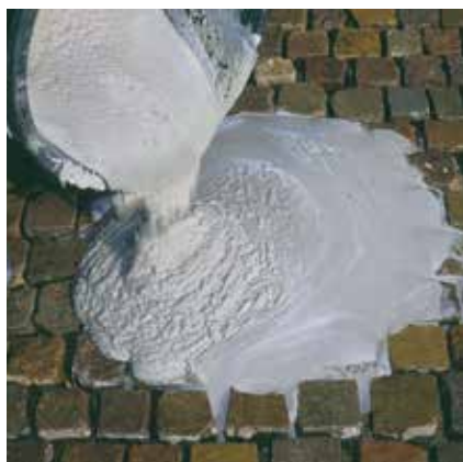
Nanoszenie fugi Sopro EPF na okładzinę brukową.
