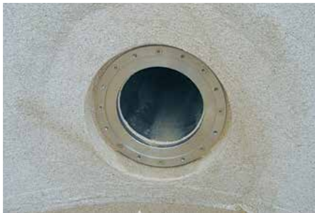
Prawidłowe przygotowanie obudowy reflektora z kołnierzem uszczelniającym przed pracami uszczelniającymi.
