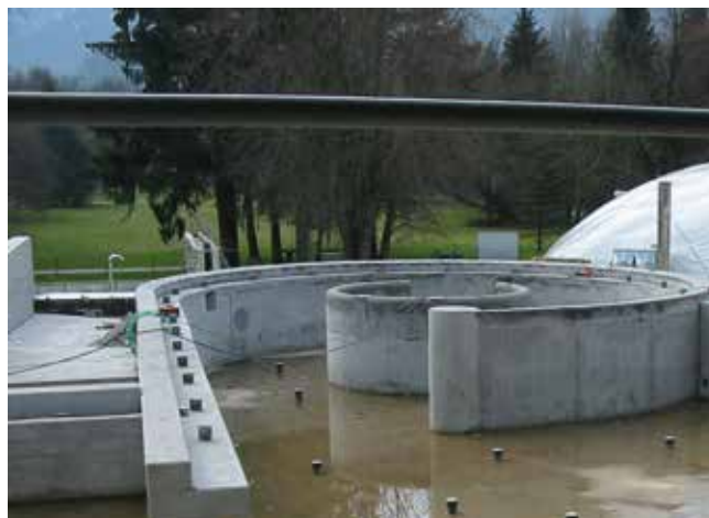
Niecka betonowa – stan surowy.
