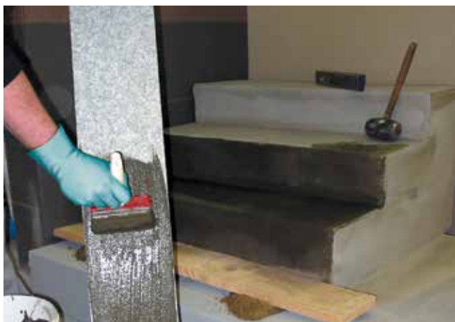
3 Przygotowanie okładziny do osadzenia poprzez naniesienie na jej spodnią stronę podkładu przyczepnego Sopro HSF 748 .
