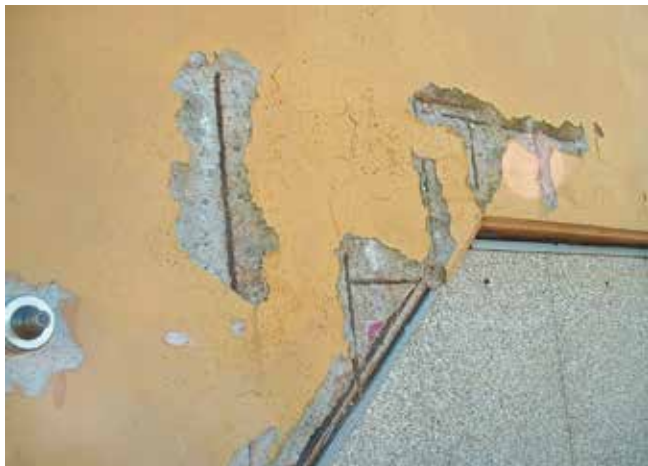
Wykruszenia w fasadzie betonowej powstałe na skutek pokrycia zbrojenia zbyt cienką warstwą betonu.
