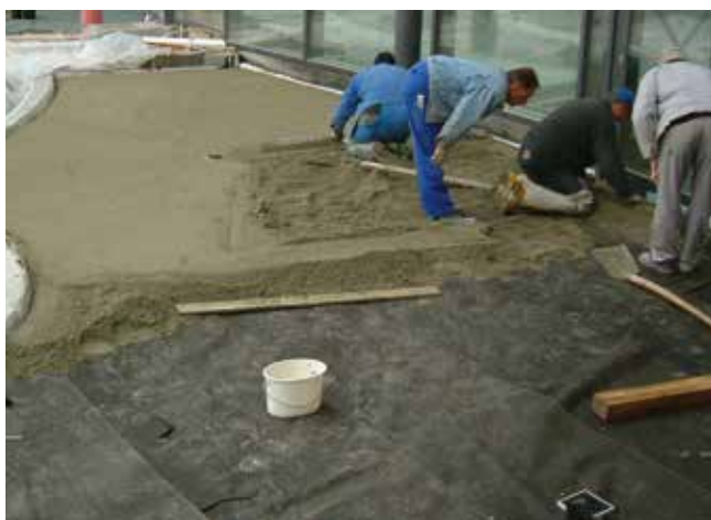
3 Tworzenie warstwy rozkładającej obciążenia przy użyciu zaprawy drenażowej Sopro DM 610 .
