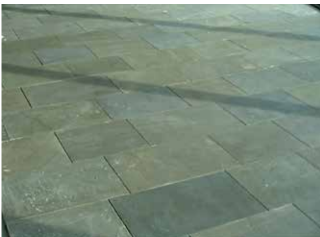
4 Gotowa powierzchnia okładziny.
