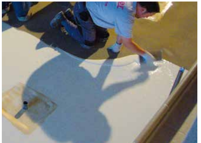
6 Uszczelnianie powierzchni niecki basenowej przy użyciu elastycznej powłoki uszczelniającej Sopro PU-FD .
