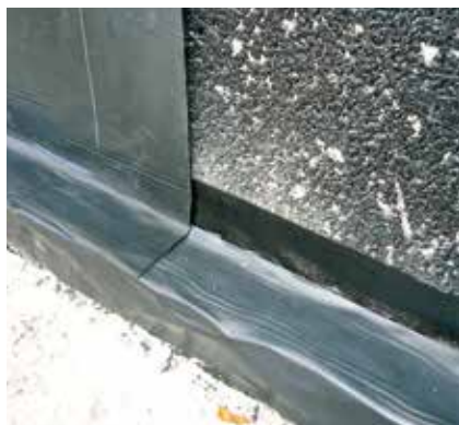
14 Obszar styku dzięki samoprzylepnej izolacji bitumicznej SoproThene® 878 jest dodatkowo zabezpieczony.
