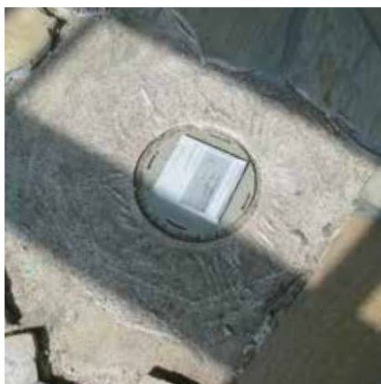
System ACO: wbudowany odpływ połączony z powłoką uszczelniającą.
