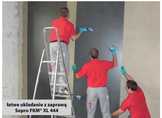
Osadzenie płyty wielkoformatowej na ścianie.
