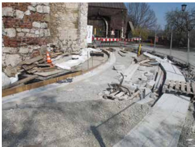
Wybetonowany fundament pod uliczny kanał odwadniający.
