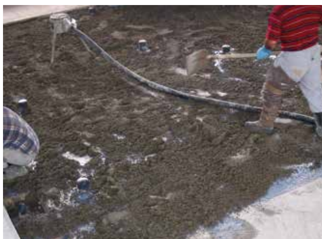
Jastrych cementowy przygotowany w konsystencji wilgotnej ziemi.
