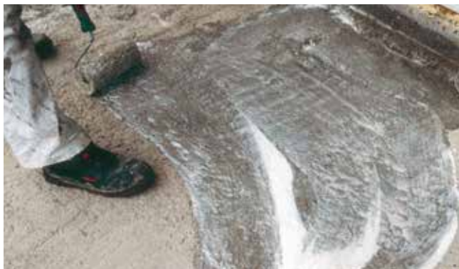
Przygotowanie podłoża z zastosowaniem emulsji przyczepnej Sopro HE 449 metodą „mokre na mokre”.
