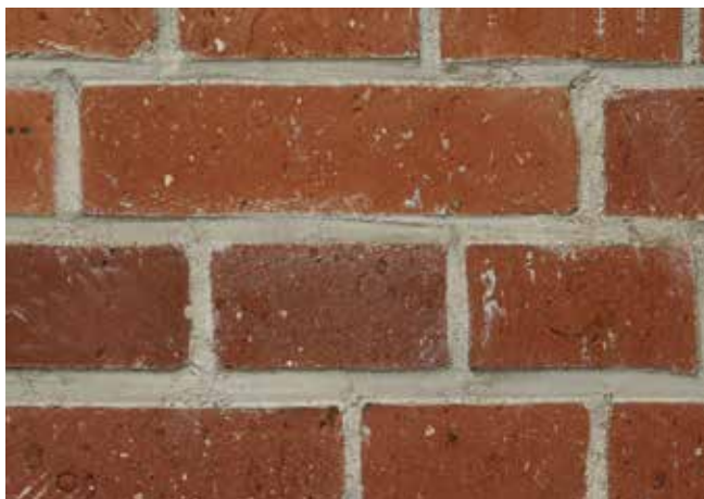
Mur po renowacji.
