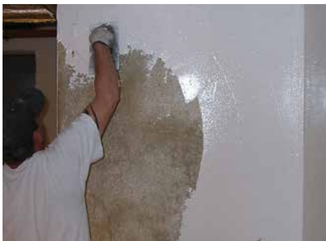
4 Nanoszenie elastycznej powłoki uszczelniającej Sopro PU-FD 570 na ścianę w dwóch warstwach o łącznej grubości min. 1 mm.
