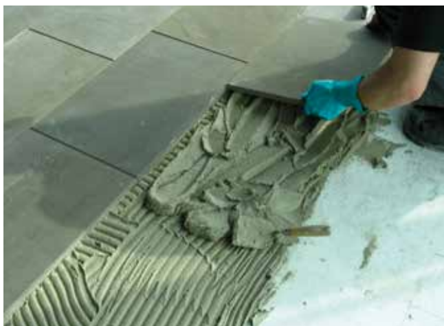
3 Układanie okładziny z kamienia naturalnego metodą średniowarstwową przy użyciu zaprawy klejowej elastycznej z trasek Sopro TR 414 .
