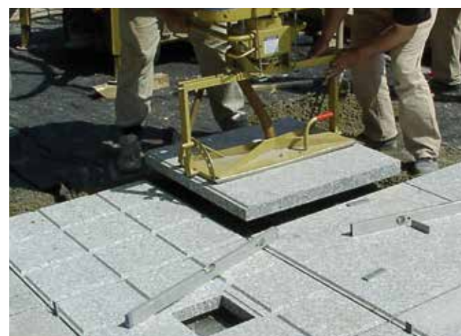
6 Maszynowe układanie płyt metodą grubowarstwową. Zaprawa kontaktowa Sopro HSF 748 została wcześniej naniesiona na spód płyty.
