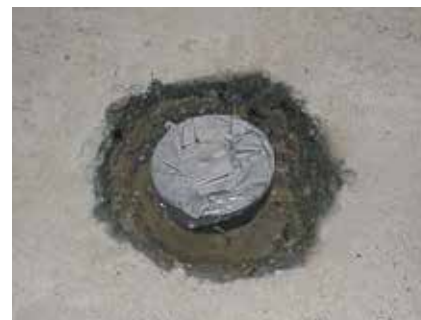
Miejsce na wypełnienie zaprawą klejową antykapilarną.
