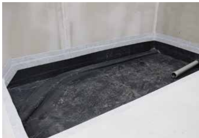
4 Gotowa, oklejona SoproThene® 878 powierzchnia pod wanną. Krawędzie oklejone taśmą pod uszczelnienie zespolone Sopro FDF 525 .
