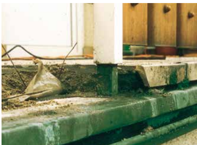
Jastrych, który utracił wytrzymałość z powodu stałego wnikanie wody.
