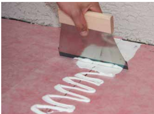
8 Rozprowadzenie kleju montażowego Sopro Racofix® RMK 818 w obszarze styku przy pomocy szpachli zębatej.
