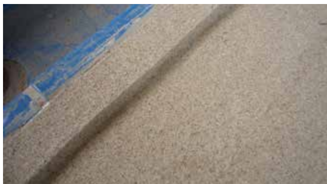
Wykonanie fugi antykapilarnej za rynną przelewową stanowi idealne rozwiązanie.
