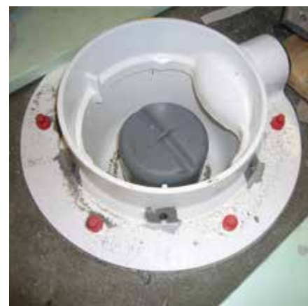
Odpyw podłogowy z kołnierzem przygotowany do uszczelnienia
