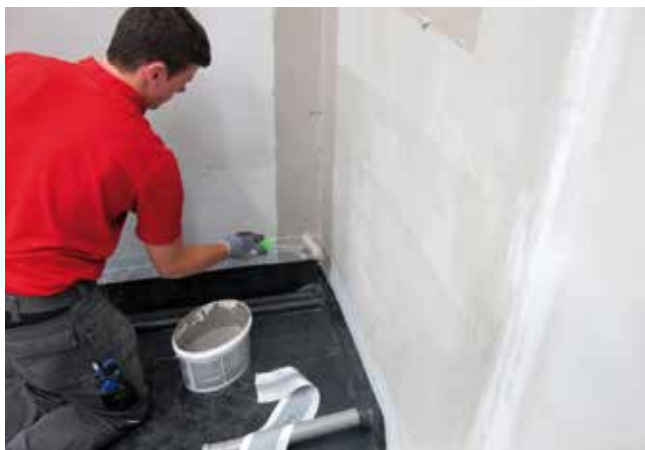
5 Uszczelnienie ściany i krawędzi zagłębienia przy pomocy Sopro FDF 525 .
