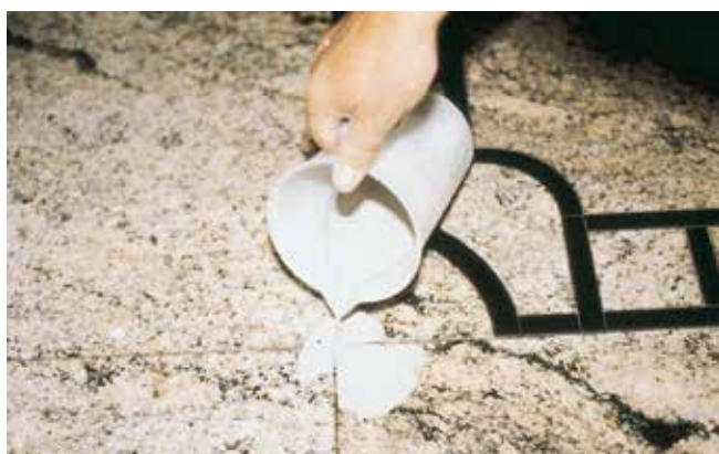
Wypełnianie przez otwartą fugę.
