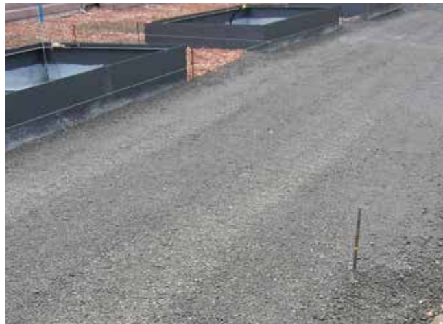
Związana warstwa nośna (beton) dla średnich i dużych obciążeń.
