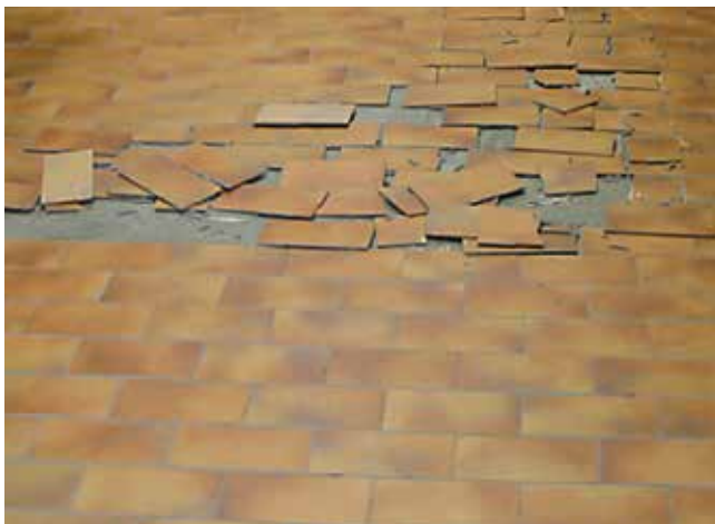
Odpadanie płytek na skutek ułożenia okładziny na zbyt świeżym betonie.
