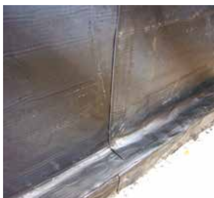
17 Uszczelnienie połączenia ściany piwnicy z płytą fundamentową.
