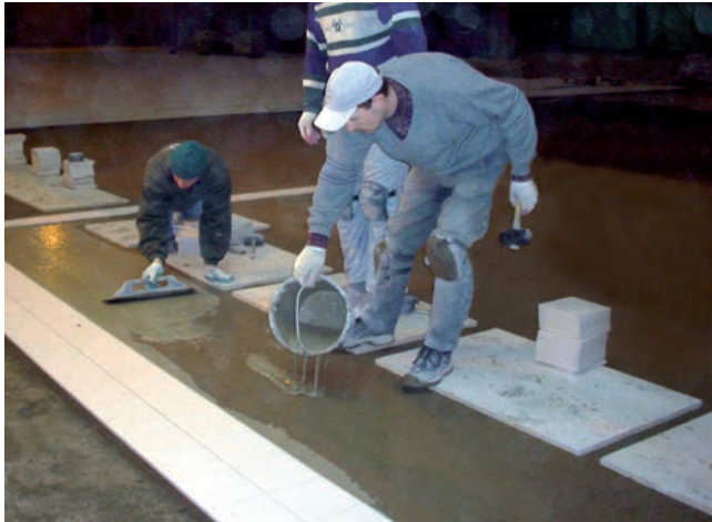
Nanoszenie podkładu przyczepnego na przygotowaną zaprawę grubowarstwową.
