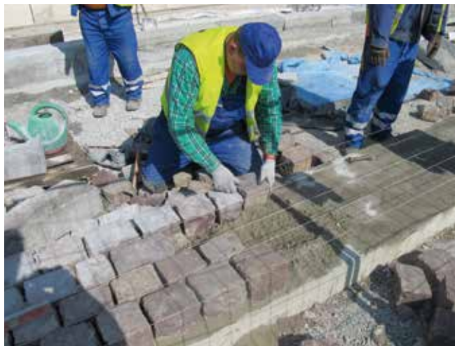
Kostka kamienna układana na betonowym podłożu.
