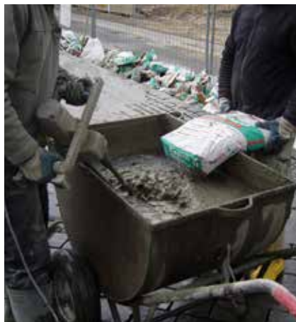
Mieszanie zaprawy fugowej mieszadłem.
