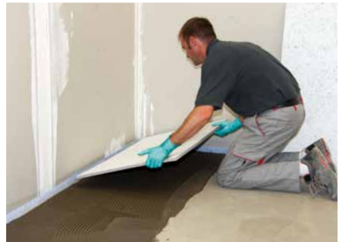
10 Układanie płyt izolacyjnych Sopro FDP 558 (9 mm) na zaprawie klejowej.
