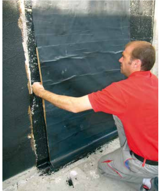
Uszczelnienie piwnicy samoprzylepną izolacją bitumiczną SoproThene® 878 zgodnie z normą DIN 18195-4.
