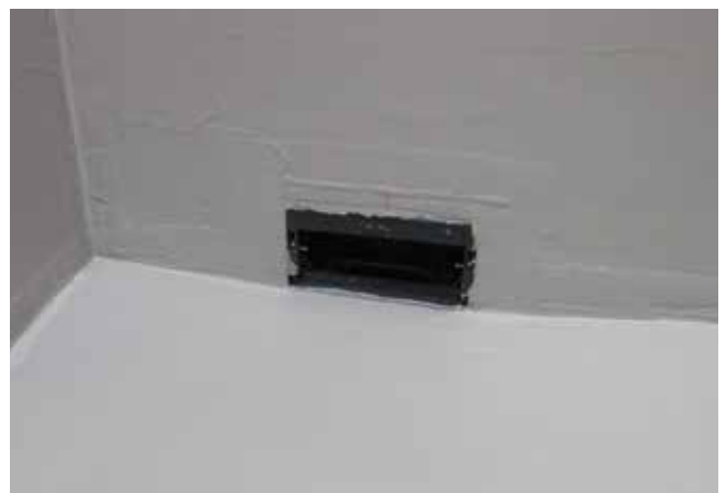
6 Powierzchnia ścian i posadzki, po przeschnięciu uszczelnienia zespolonego, gotowa do układania płytek.
