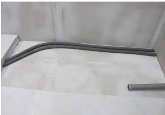
1 Zagłębienie powierzchni pod wannę z instalacją zasilającą w świeżo przygotowanej posadzce.
