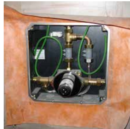
... lub z uszczelką do zatopienia w masie uszczelniającej.
