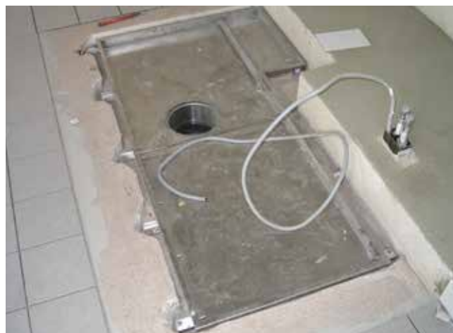
Odwodnienie osadzone w uszczelnionym zagłębieniu.
