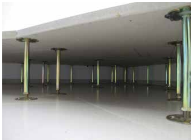
Konstrukcje podłóg podniesionych mogą być wykonane na podporach o różnej wysokości (w zależności od instalacji technicznych).
