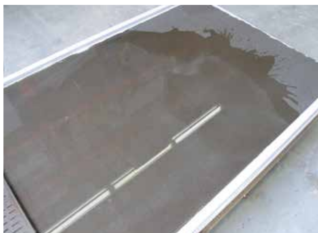
Spiętrzająca się woda przy krawędzi odpływu na powierzchni natrysku.
