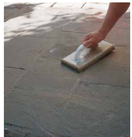
Czyszczenie małych powierzchni packą z gąbką.
