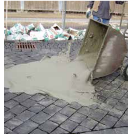
Proste wypełnianie spoin dzięki doskonałej rozpiływności zaprawy fugowej.
