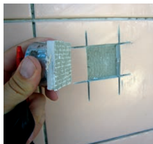
Sprawdzenie przyczepności ułożonej okładziny ceramicznej
