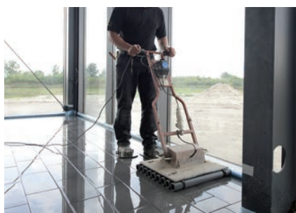
Wibrowanie świeżo ułożonej okładziny ceramicznej.
