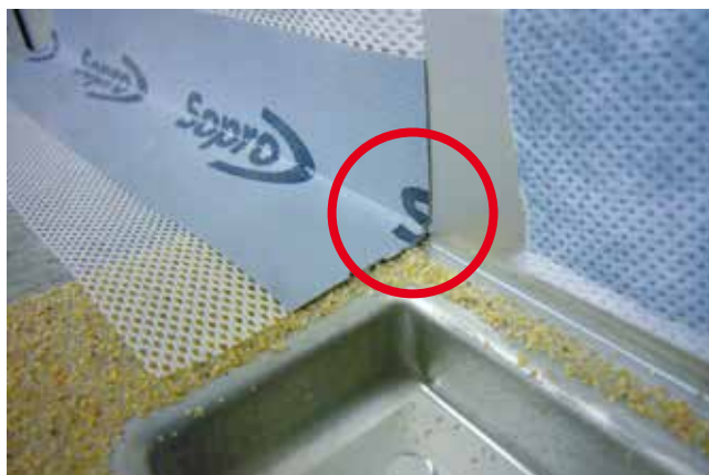
Taśma dokładnie przylega do stalowej powierzchni kołnierza.
