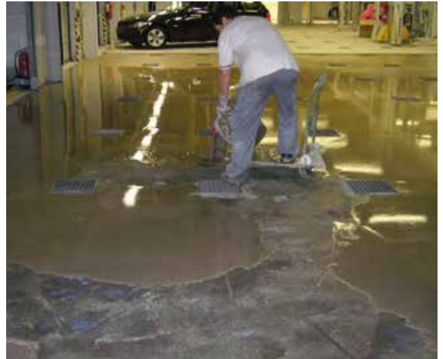
Wyrównywanie powierzchni z użyciem Sopro FS 45.
