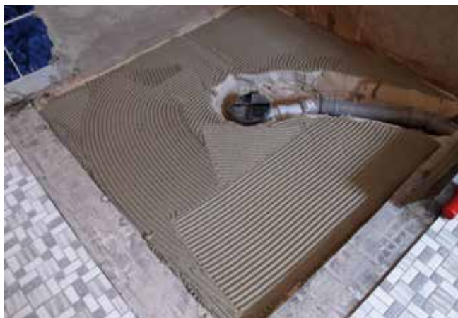
3 Element prysznicowy osadzany na zaprawie klejowej ( Sopro No.1 400 ).
