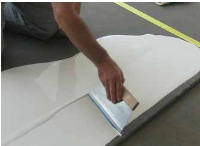
7 Uszczelnianie podłogi przy użyciu Sopro PU-FD 571 .
