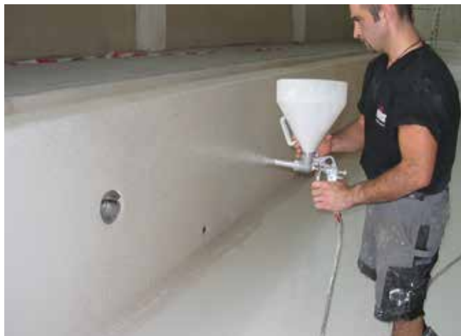
8 Wykonywanie posypki z piasku kwarcowego Sopro QS na Sopro PU-FD 570 .
