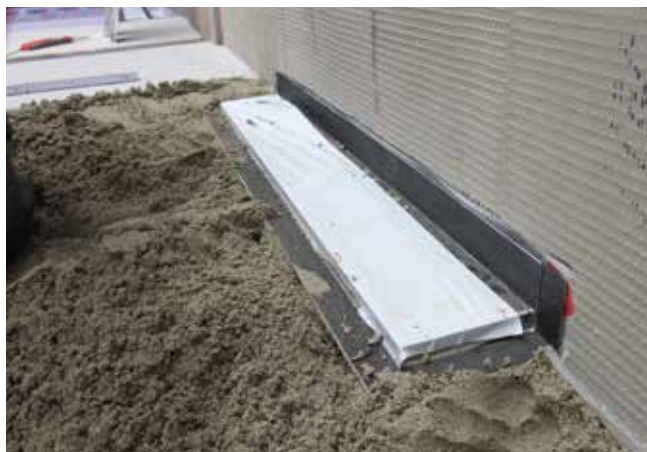
2 Osadzenie odwodnienia liniowego w świeżej warstwie jastrychu ( Sopro Rapidur® B5 ).
