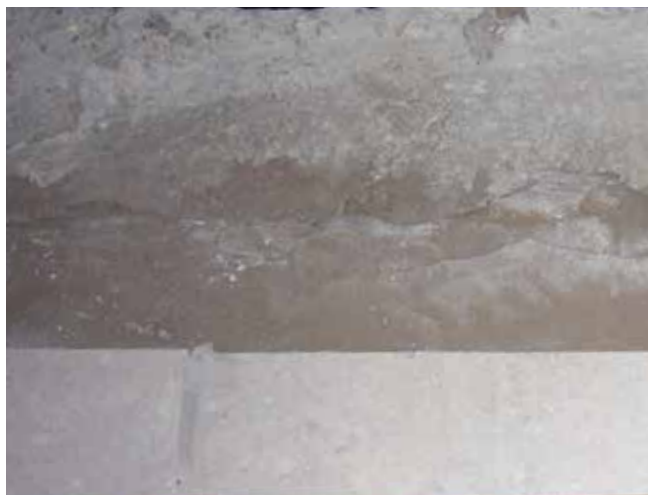
Mostek akustyczny spowodowany zaprawą klejową.
