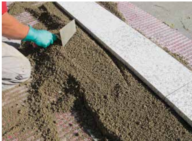
2 Przygotowanie zaprawy drenażowej Sopro DM 610 do układania płyt metodą "mokre na mokre".
