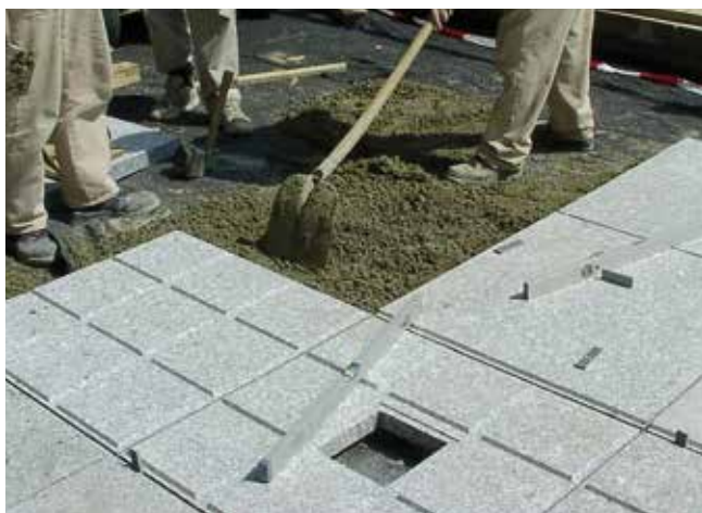
5 Rozkładanie zaprawy drenażowej Sopro DM 610 pod kamień naturalny układany metodą grubowarstwową.
