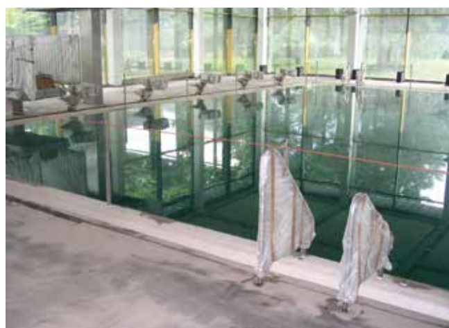
10 Próba wodna (minimum 14 dni).
