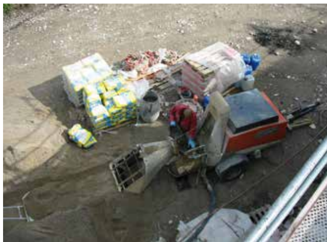
Wytworzenie jastrychu cementowego przy pomocy pompy.
