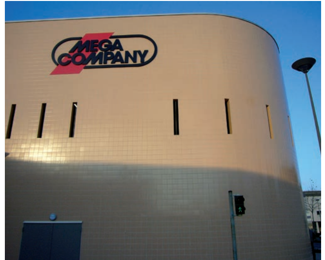
Elewacja obłożona płytkami ceramicznymi.
