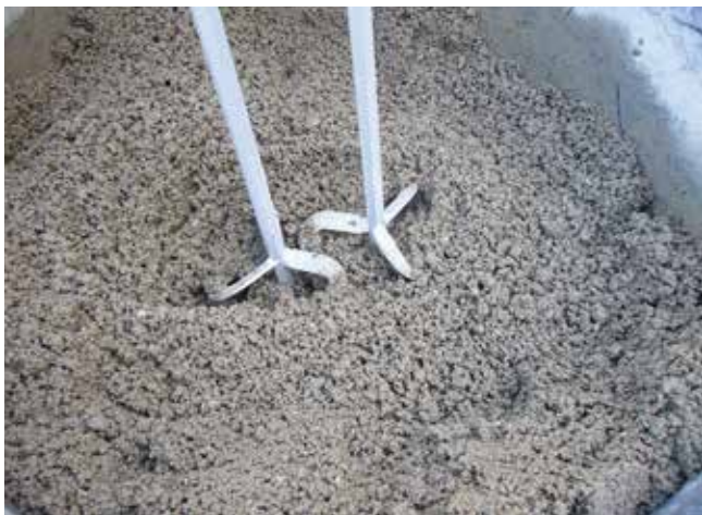
Przygotowanie zaprawy drenażowej, stosowanej jako podsypki, przy pomocy mieszadła lub betoniarki przeciwbieżnej.
