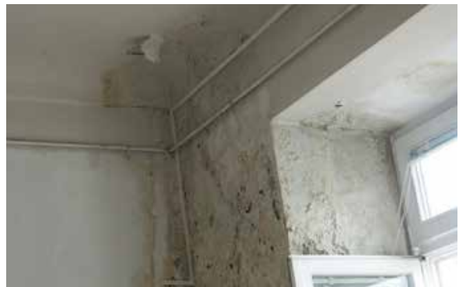
Wilgoć powoduje rozwój mikroorganizmów, a w konsekwencji odpadanie farb i tynków.
