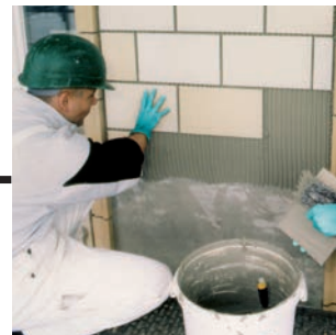
Metoda kombinowana – nałożenie warstwy kontaktowej na spodnią powierzchnię płyty i ułożenie jej na przygotowaną warstwę grzebieniową na podłożu.
