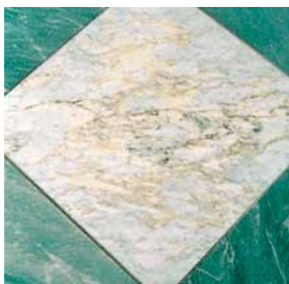
Przebarwienia krawędzi i zmiany odcienia w obrębie płyty, spowodowane wysoką zawartością wody w zaprawie grubowarstwowej.
