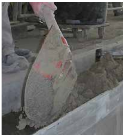
Nakładanie zaprawy jastrychowej ( Sopro Rapidur® M5 ) metodą „mokre na mokre” na zalecany preparat gruntujący Sopro EPG 522 .
