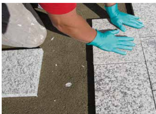
6 Układanie płytek kamiennych (z naniesioną warstwą grzebielową na spodniej stronie) na jastrychu drenażowym.
