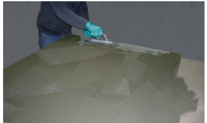
Naniesienie warstwy kontaktowej z zaprawy klejowej Sopro FKM® XL 444 na spodnią stronę płyty wielkoformatowej.
