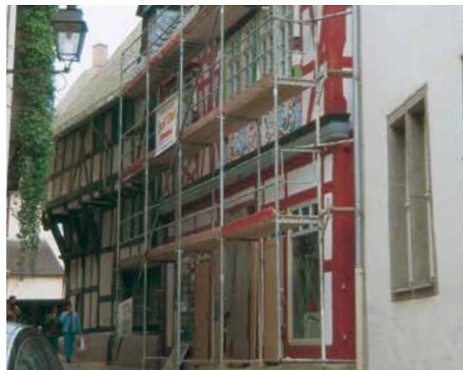
Remonty starych budowli.
