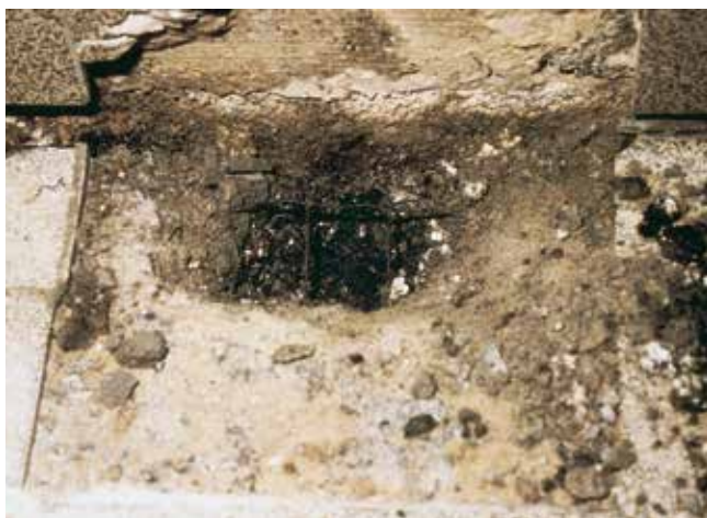
Zawilgocony jastrych z powodu braku uszczelnienia zespolonego – problem higieniczny np. w kuchniach.
