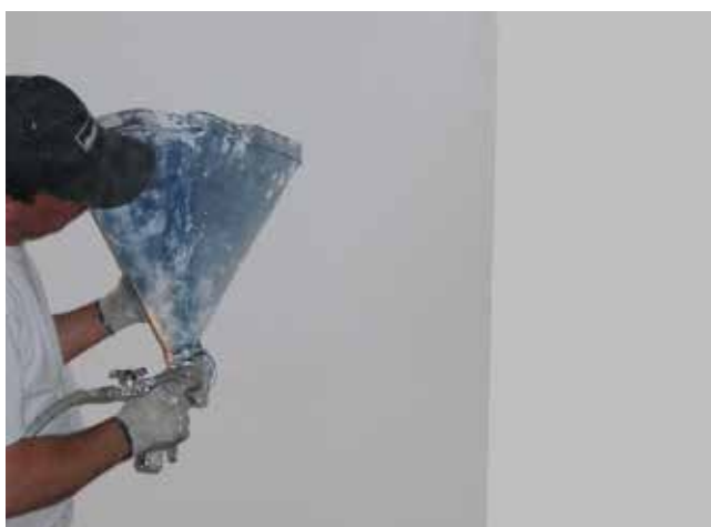
6 Nanoszenie piasku kwarcowego na świeżo położoną drugą warstwę elastycznej powłoki uszczelniającej Sopro PU-FD .
