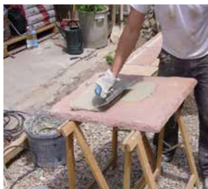
Dla trwałości konstrukcji, szczególnie przy układaniu dużych płyt zasadnicze znaczenie ma naniesienie podkładu przyczepnego na spód płyty i obróbka metodą „mokre na mokre”.
