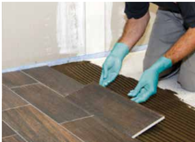
16 Układanie płytek ceramicznych w przygotowanej warstwie zaprawy Sopro VF XL 413 .
