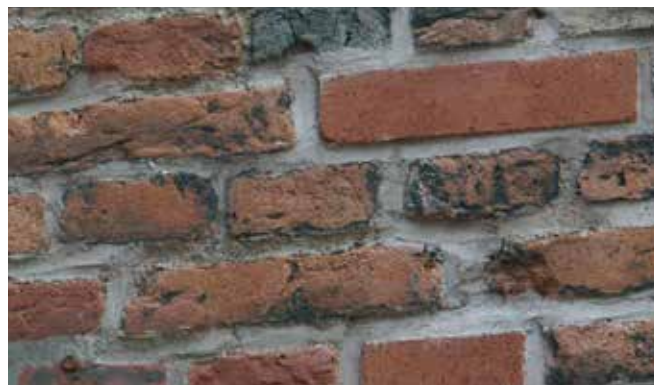
Wymienione cegły w murze licowym.
