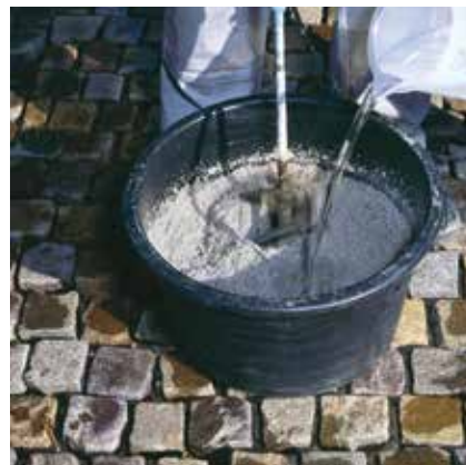
Mieszanie fugi epoksydowej Sopro EPF z dodatkiem wody.
