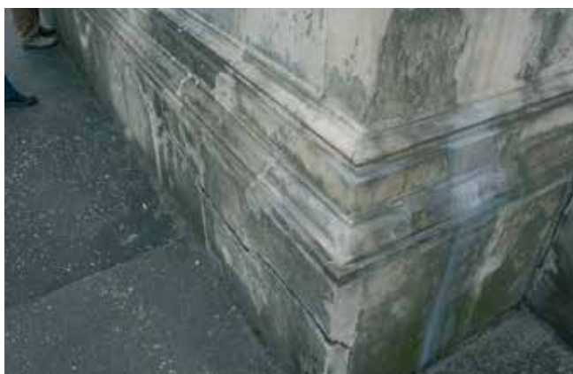
Wpływ oddziaływania śniegu i wody rozpryskowej na cokół kamienny budynku.
