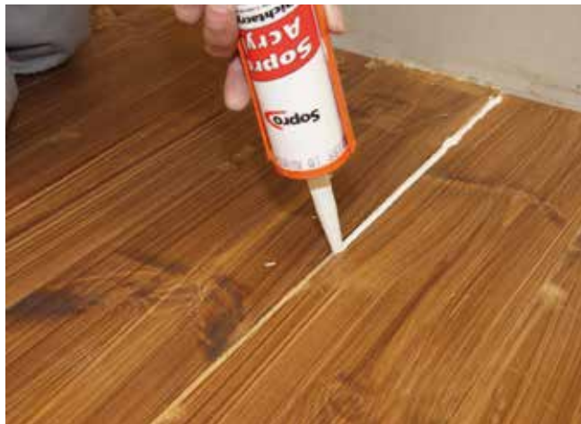
4 Aby samopoziomująca masa szpachlowa, zastosowana przy pracach wyrównawczych, nie wyciekła przez szczeliny podłogi drewnianej, należy wypełnić je akrylem.
