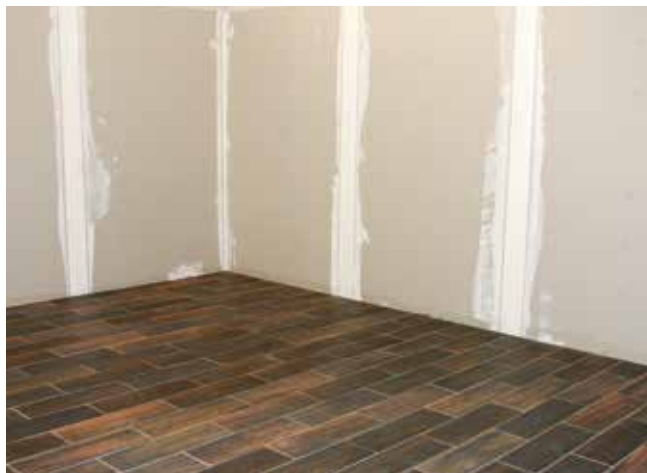
18 Gotowa okładzina ceramiczna na drewnianym podłożu.
