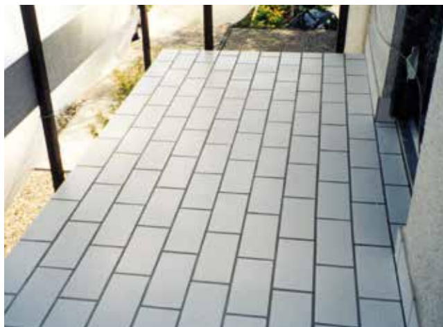
Balkon z okładziną ceramiczną.
