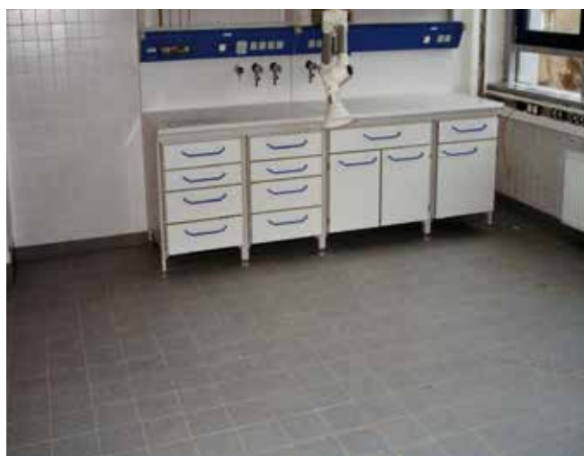
Pomieszczenie laboratorium, zagrożone wybuchem
