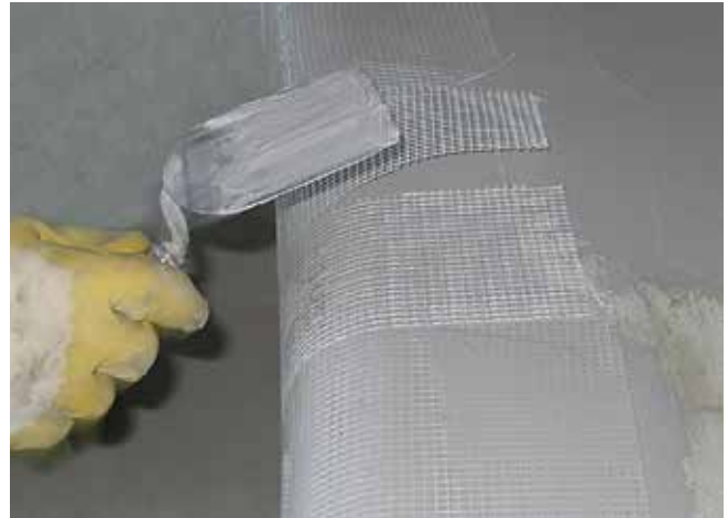
4 Wklejenie siatki z włókna szklanego w uszczelnienie zespolone w obszarze podwodnym.
