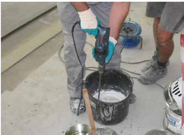
5 Dokładne wymieszanie elastycznej powłoki uszczelniającej Sopro PU-FD .
