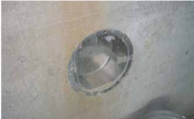
Wbudowany reflektor wyposażony jest tylko w kilkumilimetrowy kołnierz.
