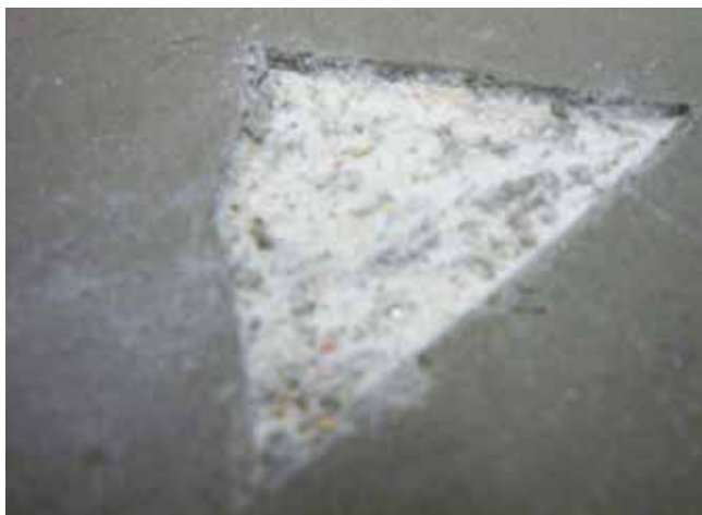
Miejsce po wycięciu próbki uszczelnienia.
