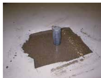
Wypełnienie antykapilarne przepustu mieszaną epoksydowo-piaskową ( Sopro EPG 522 zmieszane w proporcji 1:1:1 z Sopro QS 507 i Sopro QS 511 ).
