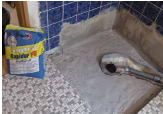
2 Wyrównanie powierzchni z użyciem zaprawy do jastrychów Sopro Rapidur® FE lub szpachli samopoziomującej Sopro FS 45 dla niezawodnego, z pełnym przyleganiem do podłoża, montażu elementu naroża prysznicowego.
