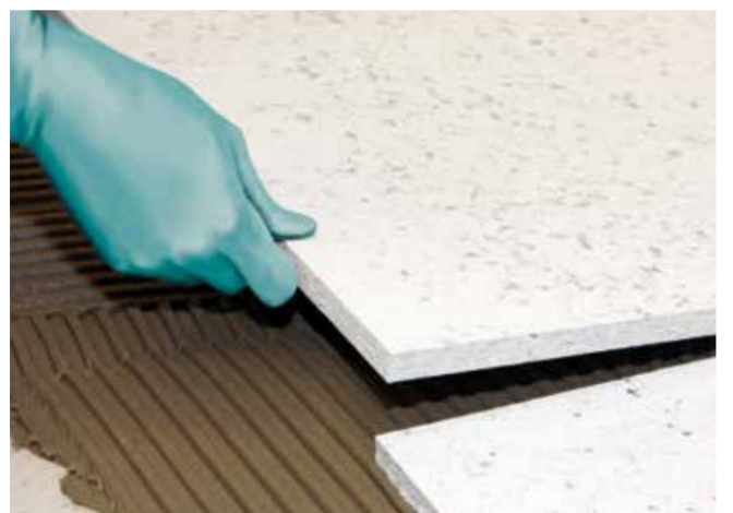
12 Płyty izolacyjne Sopro FDP 558 w prosty sposób układane są obok siebie.
