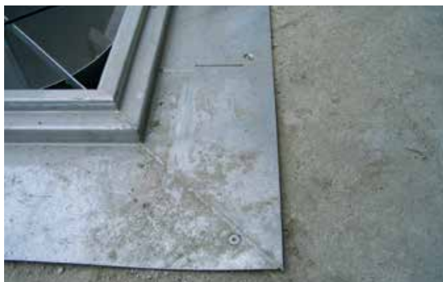
Nieka ze stali nierdzewnej z szerokim kołnierzem, na który nanosi się uszczelnienie zespolone.
