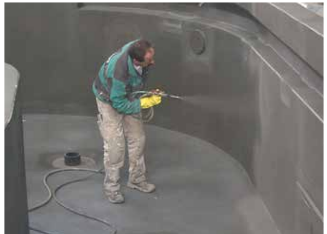
Nakładanie uszczelnienia zespolonego ( Sopro DSF® 523 ) metodą natryskową.
