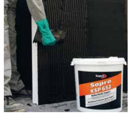
18 Po całkowitym przeschnięciu, na uszczelnienie zostają przyklejone odpowiednie maty drenażowe (np. mata ochronna Sopro KDS 663 ) lub płyty izolacyjne. W zależności od przypadku obciążenia wodą, masa Sopro KSP 652 nakładana jest na płytę punktowo lub na całą jej powierzchnię.
