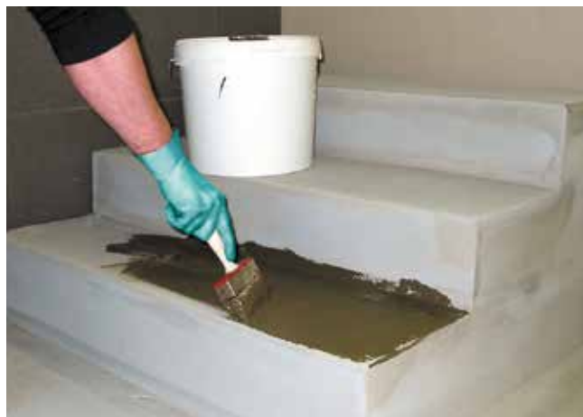
2 Naniesienie podkładu przyczepnego elastycznego z traselem Sopro HSF 748 na uszczelnienie zespolone jako warstwy kontaktowej dla zaprawy drenażowej Sopro DM 610 .
