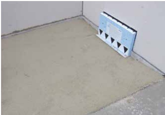
3 Gotowa powierzchnia naroża prysznicowego, wykonana przy użyciu Sopro Rapidur® M1/ Sopro Rapidur® M5 - po krótkim czasie wiązania nadająca się do dalszych prac
