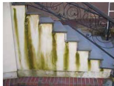
Woda wypływająca na boczne powierzchnie schodów powoduje uszkodzenia i nieestetyczne zabrudzenia.
