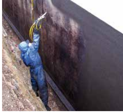
17 Natryskiwanie uszczelnienia bitumicznego.
