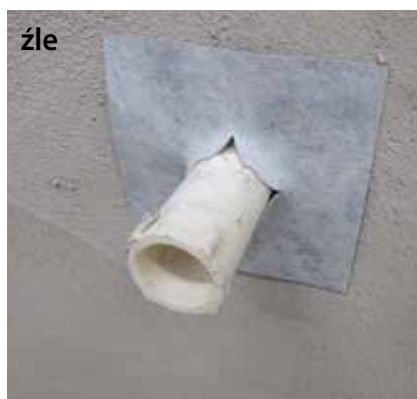
źle Uszczelka została nacięta, aby można ją było założyć na rurę.
