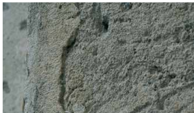
Powierzchnia tynku po czyszczeniu myjką wysokociśnieniową.
