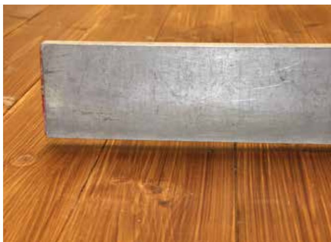
3 Podłoże należy sprawdzić pod kątem nierówności. W przypadku ich wystąpienia podłogę wyrównać.
