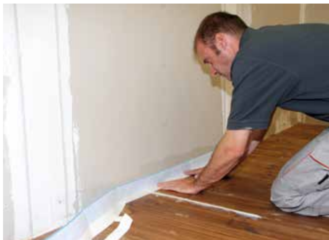
5 W miejscach styku ścian i podłogi zamontować taśmy izolacji brzegowej.
