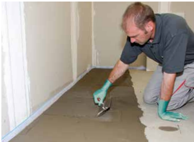
9 Jeśli podłoże drewniane jest równe, bezpośrednio na preparat gruntujący Sopro HPS 673 nałożyć zaprawę np. Sopro VF XL 413 w celu przygotowania powierzchni pod płyty izolacyjne Sopro FDP 558 .
