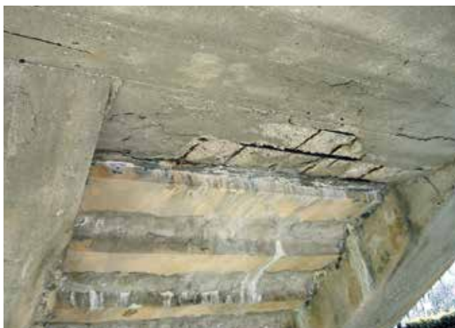
Uszkodzenia spowodowane korozją na spodniej stronie konstrukcji schodów, powstałe na skutek braku uszczelnienia i zbyt cienkiej warstwy betonu, pokrywającego zbrojenie.
