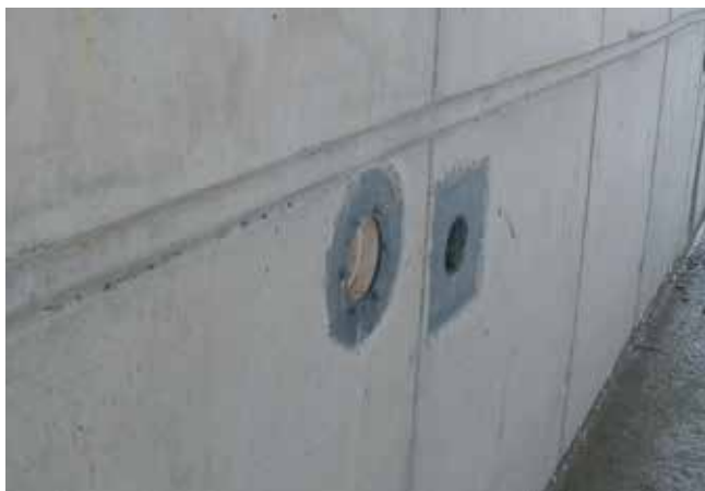
Wyźłobienie wykonane w stanie surowym.
