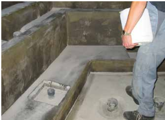
1 Nanoszenie preparatu epoksydowego Sopro EPG 522 z posypką z piasku kwarcowego Sopro QS 507 .
