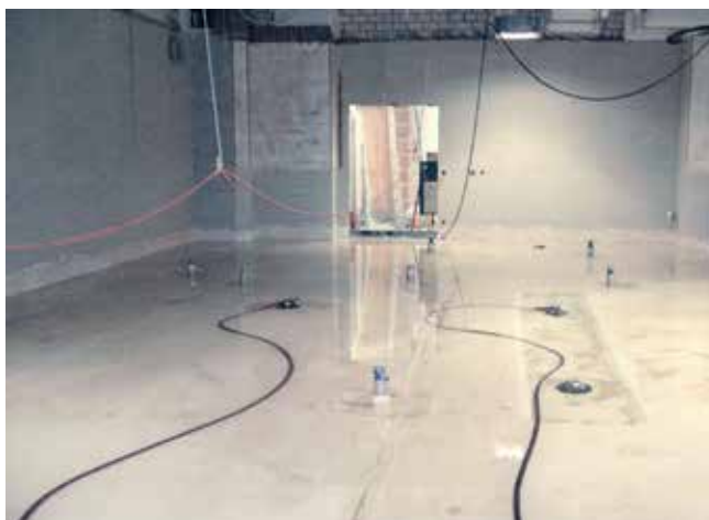
Próba szczelności uszczelnienia podłogowego.
