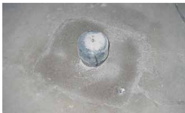
Przepust podłogowy wypełniony antykapilarną mieszanką preparatu epoksydowego Sopro EPG 522 i piasku kwarcowego Sopro QS.
