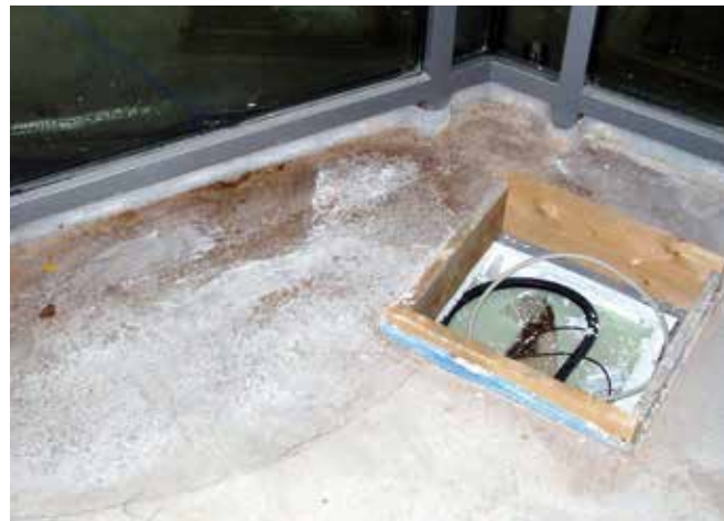
Problemy z odpornością i zjawiskiem rozpuszczania się jastrychu anhydrytowego na skutek wystąpienia wody.
