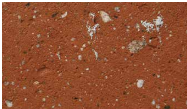
Powierzchnia cegły po czyszczeniu mechanicznym.
