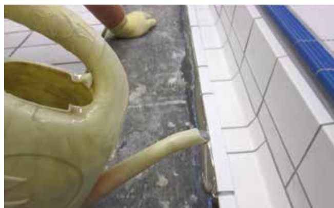
Wykonanie fugi antykapilarnej przy użyciu preparatu epoksydowego Sopro EPG 522 , zmieszanego z piaskiem kwarcowym Sopro QS 511 i Sopro QS 507 w proporcji objętościowej 1:1:1.
