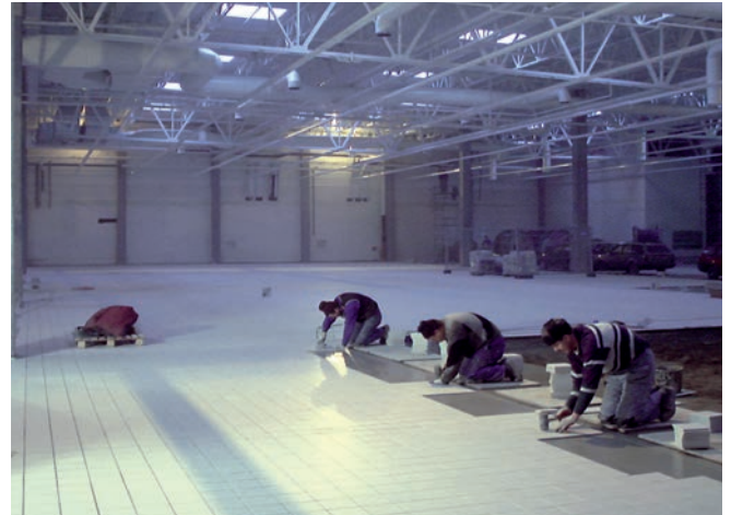
Układanie okładziny ceramicznej na świeżej warstwie podkładu przyczepnego.
