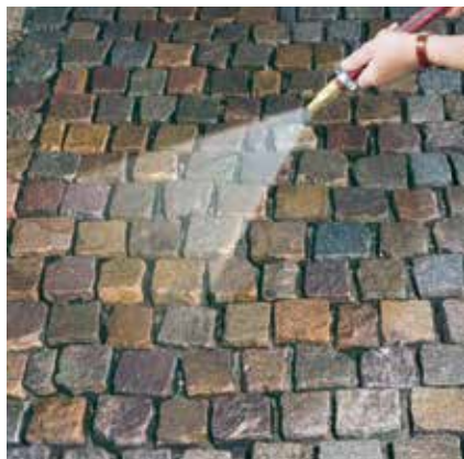
Nawilżona, oczyszczona okładzina, przygotowana do spoinowania.
