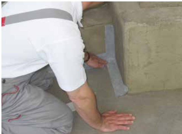
2 Wklejanie taśmy uszczelniającej Sopro FDB 524 w naroża.
