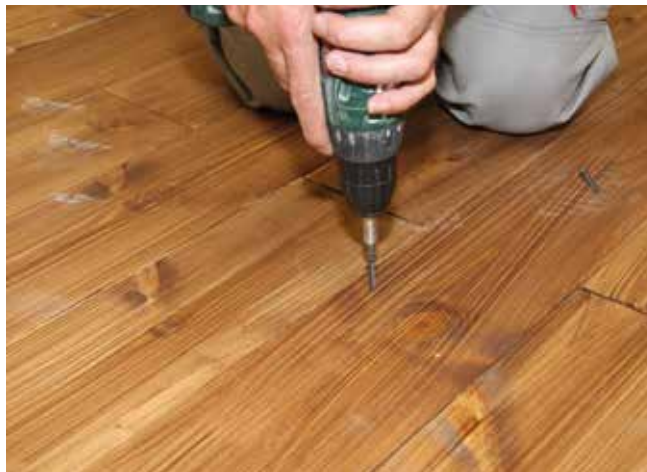
2 Mocowanie desek do konstrukcji nośnej przy pomocy wkrętów do drewna.
