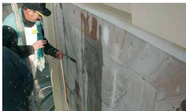
Sposób aplikacji Soproduru® 900 na ścianach.
