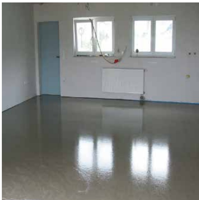
Gładka powierzchnia podłogi, po związaniu odporna na ścieranie.
