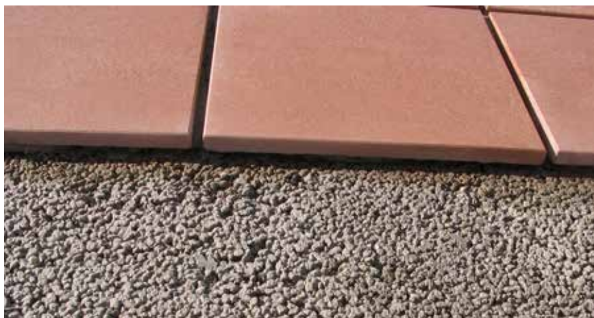
Układanie płytek na zaprawie drenażowej metodą cienkowarstwową
