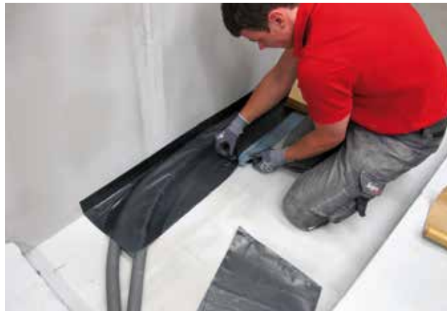
2 Uszczelnianie obszaru pod wanną samoprzylepną izolacją bitumiczną SoproThene® 878 .
