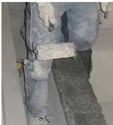
Nakładanie preparatu epoksydowego Sopro EPG 522 jako mostka szczepnego.
