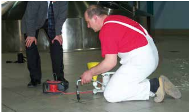
Wstrzykiwanie za pomocą techniki iniekcyjnej (15 barów).
