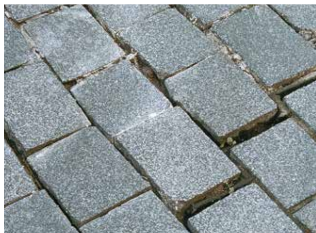
Przesunięta okładzina na skutek brakującego wypełnienia i odpowiednio wysokich obciążeń użytkowych.
