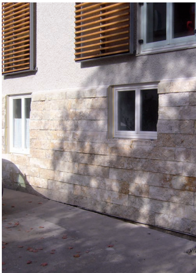
Osadzenie kamienia naturalnego na elewacji.
