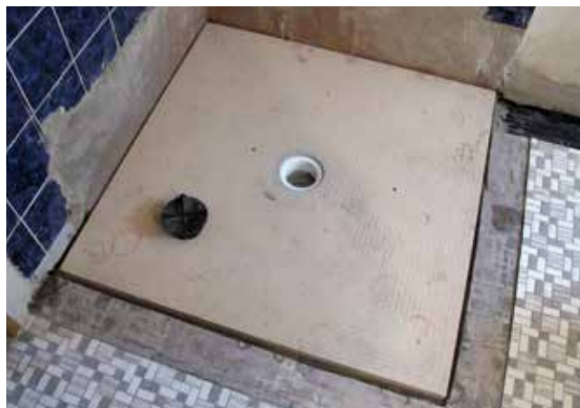
4 Zamontowany element naroża prysznicowego (MEPA – Pauli und Menden GMBH) gotowy do wykonania prac uszczelniających.
