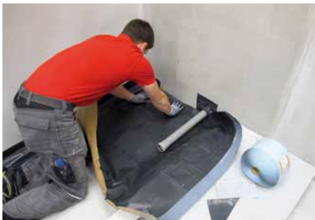
3 Uszczelnienie powierzchni i połączenia przejścia rur (odpływowych) SoproThene® 878 .
