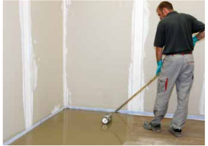
8 Szpachlę Sopro FAS 551 rozprowadzić i odpowietrzyć przy pomocy walca z kołkami, aby uzyskać równą powierzchnię podłoża.
