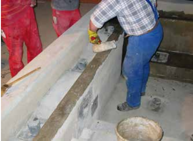
1 Gruntowanie powierzchni przy użyciu preparatu epoksydowego Sopro EPG 522 . Zużycie zależy od chłonności podłoża.
