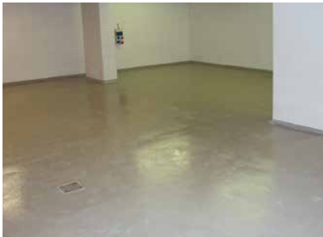
Pokrycie posadzki pomieszczenia na odpady, wykonane przy pomocy epoksydowego lakieru do betonu – wysokowytrzymałego SoproDur® HF-L . Ściany obłożone płytkami ceramicznymi.
