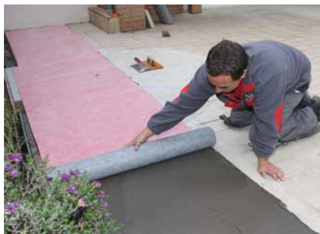
4 Ułożenie maty uszczelniająco-odcinającej Sopro AEB® 639 plus na przygotowanej, świeżej zaprawie cienkowarstwowej.
