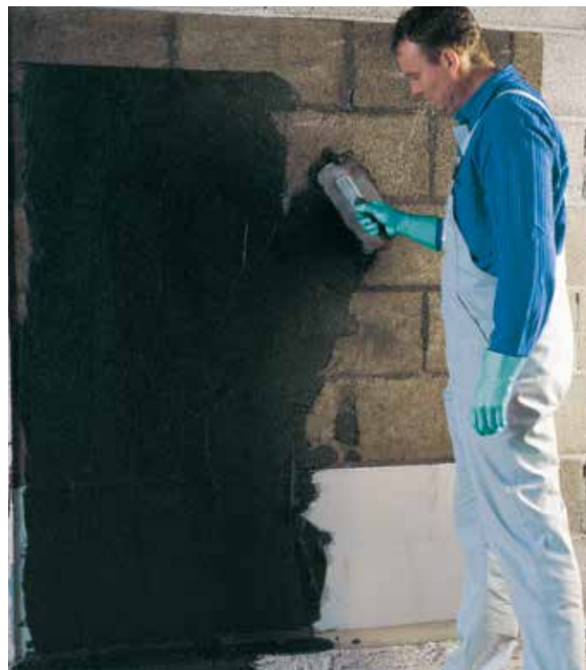
Nakładanie bitumicznego uszczelnienia grubowarstwowego.
