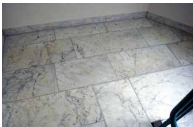
Żółte przebarwienia na okładzinie, wywołane przez występujące w kamieniu związki żelaza, które mogą się uaktywnić pod wpływem wilgoci pochodzącej z zaprawy grubowarstwowej.
