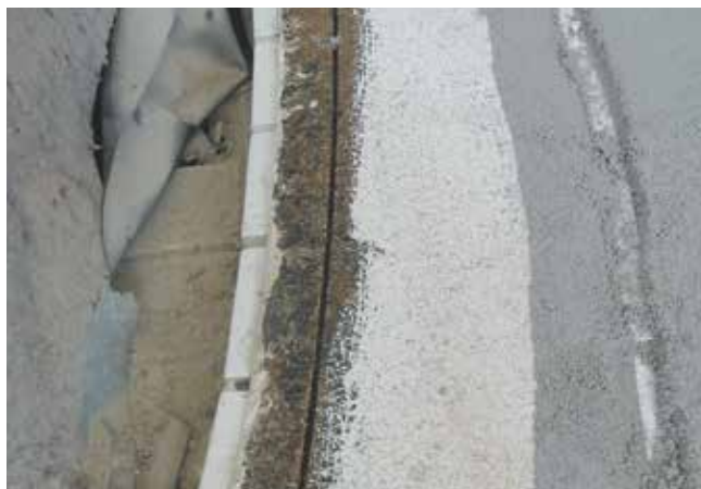
Wyźłobienie w niecce basenowej do uszczelnienia na powierzchni niecki.
