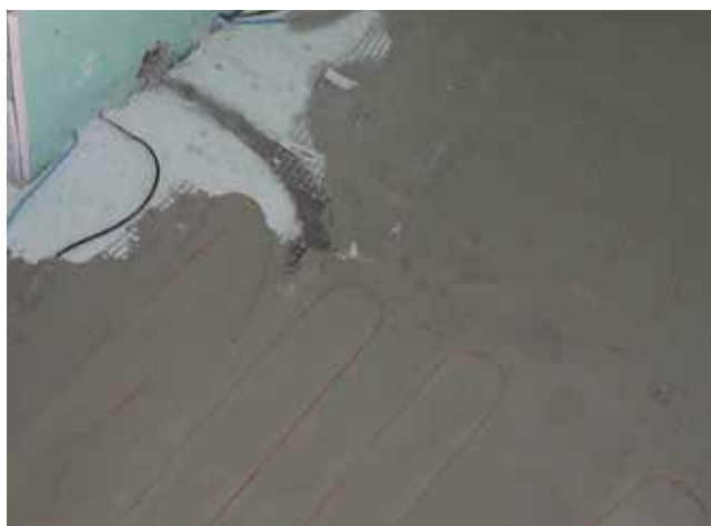
Elektryczna mata grzewcza zatopiona w zaprawie klejowej Sopro FKM® XL 444 .
