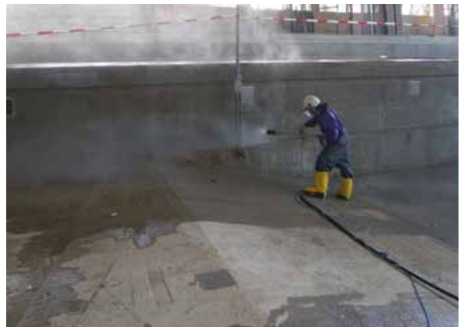
Piaskowanie betonu w celu uzyskania optymalnej, szorstkiej, nośnej powierzchni betonowej.
