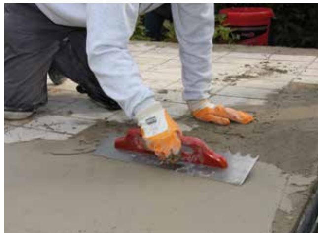
2 Wyrównanie uszkodzeń szpachlą wyrównawczą z trasek Sopro AMT 468 przed rozpoczęciem prac uszczelniających.
