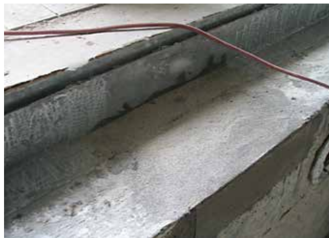
Skrzynka odpływowa pokryta żywicą reaktywną i siatką.
