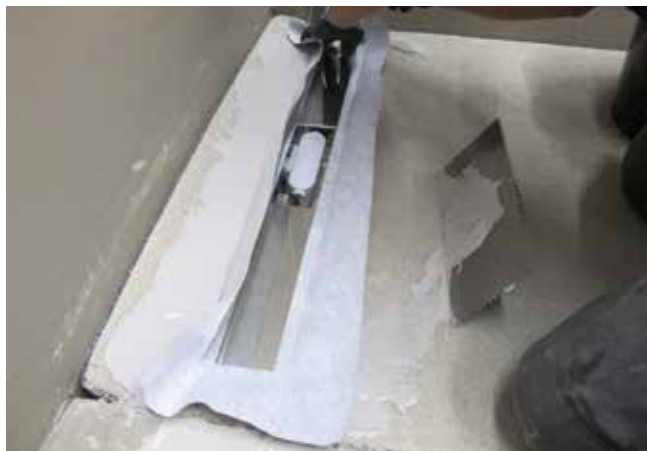
3 Wklejenie kołnierza uszczelniającego na zaprawie Sopro DSF® 523 .
