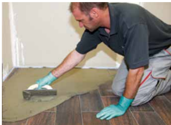
17 Fugowanie płytek fugą elastyczną Sopro FL lub Sopro DF 10® .
