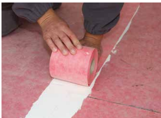
9 Uszczelnienie obszaru styku mat przy pomocy taśmy uszczelniającej Sopro AEB® 641 .
