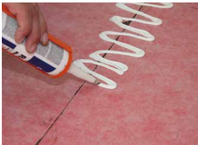
7 Nałożenie kleju montażowego Sopro Racofix® RMK 818 do uszczelnienia połączeń krawędzi mat Sopro AEB® 639 plus .
