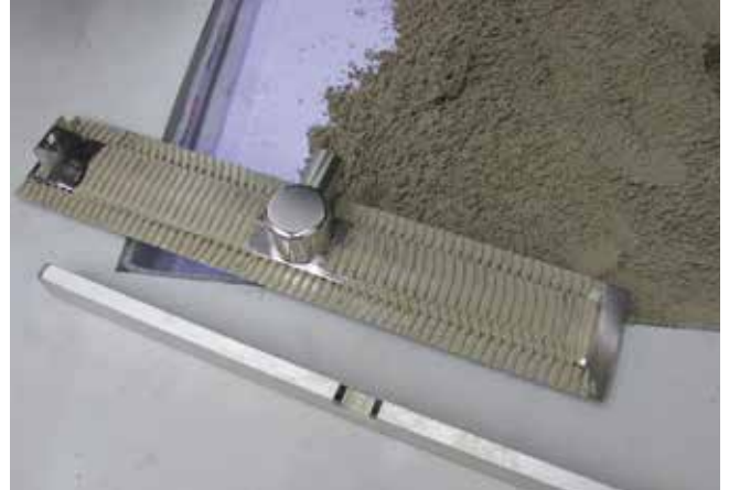
2 Odwodnienie liniowe ACO, pokryte na spodniej części zaprawą klejową ( Sopro No.1 400 jako warstwa kontaktowa) i osadzone w warstwie świeżego jastrychu ( Sopro Rapidur® M1/ Sopro Rapidur® M5 ).
