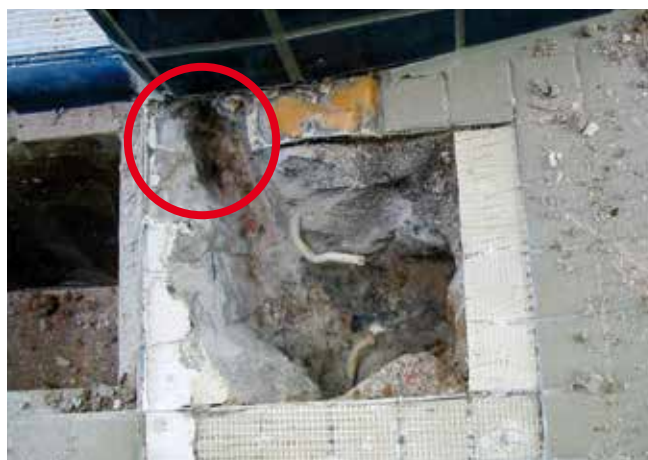
Niekontrolowany przepływ wody na zakończeniu rynny na powierzchnię wokółbasenową.
