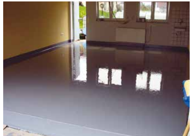
Powierzchnia garażu wykończona epoksydowym lakierem do betonu - wysokowytrzymałym SoproDur® HF-L .
