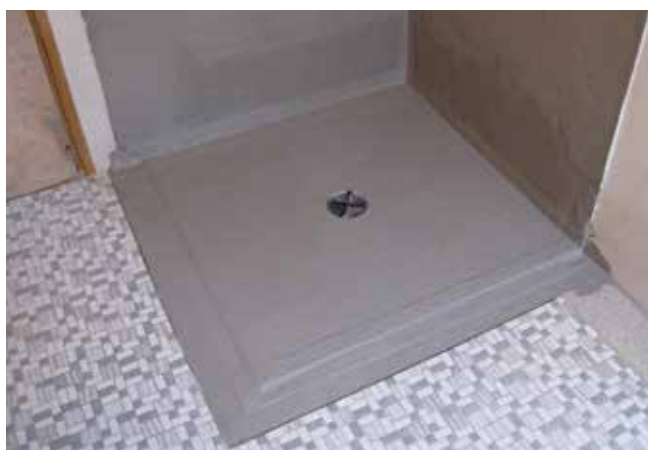
5 Odpływ uszczelniony Sopro FDF 525 w dwóch warstwach.
