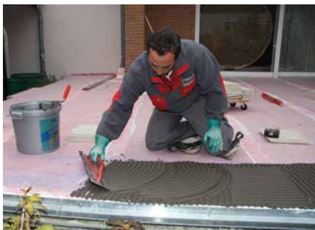
11 Nałożenie warstwy grzebieniowej zaprawy klejowej Sopro MEG 666 .
