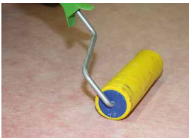
5 Dociśnięcie maty Sopro AEB® 639 plus do warstwy zaprawy klejowej.
