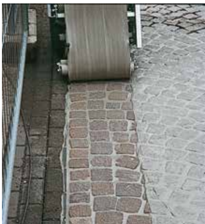
Czyszczenie dużych powierzchni przy pomocy maszyny zmywającej.
