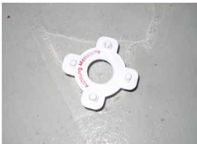
Zaznaczanie miejsca pomiaru na ogrzewanym jastrychu celem uniknięcia uszkodzenia przy pomiarach aparatem CM.
