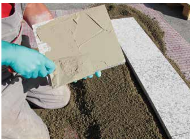
3 Naniesienie zaprawy kontaktowej ( Sopro HSF 748 ) na spód płyty z kamienia naturalnego.
