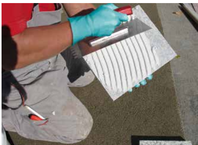
5 Naniesienie zaprawy cienkowarstwowej na spód płytki.
