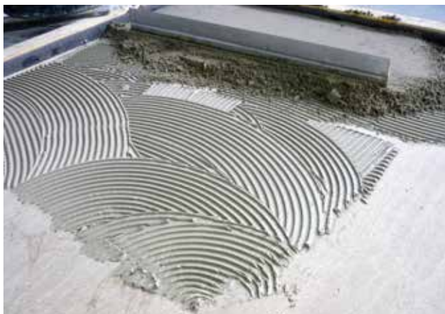
Elastyczna zaprawa klejowa pozwala na wytworzenie odpowiedniego podkładu przyczepnego pod jastrych, metodą „mokre na mokre”.
