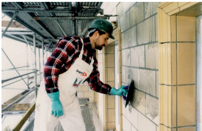
Spoinowanie hydraulicznie wiążącą zaprawę fugową.
