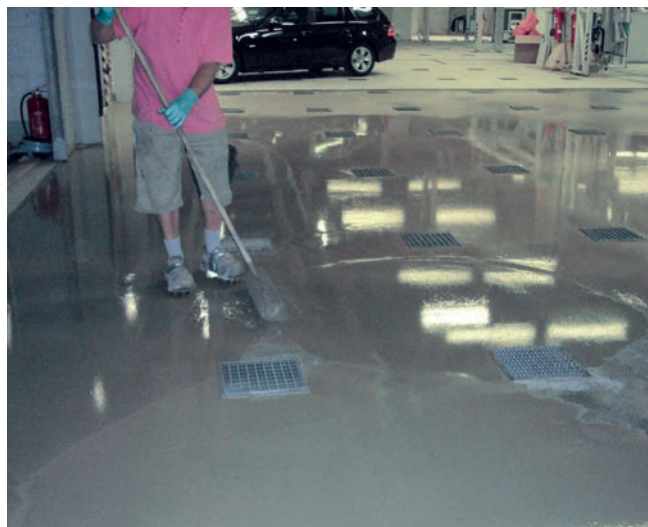
Zastosowanie szpachli samopoziomującej Sopro NSM 550 do wyrównania powierzchni.
