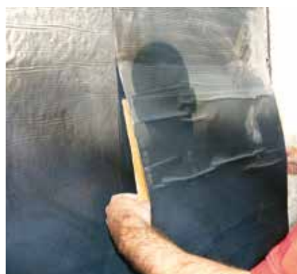
16 Przyklejanie następnego odcinka izolacji bitumicznej SoproThene® 878 .
