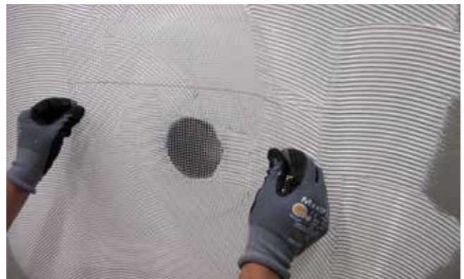
2 Ułożenie kawałka siatki zbrojącej w pierwszą warstwę uszczelnienia zespolonego.
