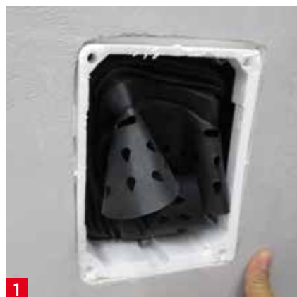
Niezawodne uszczelnienie armatury ścienniej z zastosowaniem Sopro FDF 525 lub Sopro DSF® 523 .
