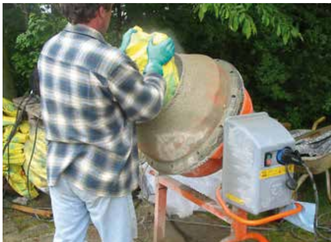
1 Mieszanie zaprawy drenażowej Sopro DM 610 w betoniarnie wolnostopadowej.
