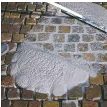
Wypełnianie szczelin zaprawą fugową.
