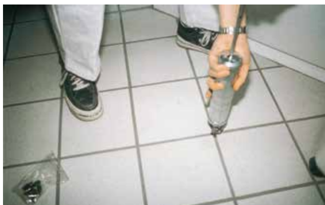
Wpompowywanie środka iniekcyjnego za pomocą strzykawki ręcznej w przypadku małych powierzchni.
