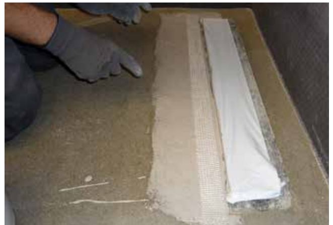
4 Uszczelnienie korpusu odwodnienia liniowego przy użyciu Sopro DSF® 523 .
