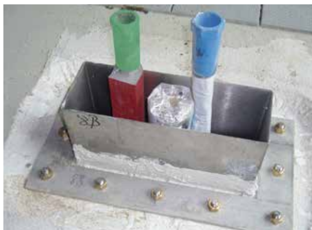
Wkładka instalacyjna z kołnierzem przystosowanym do zastosowania uszczelnienia zespolonego.
