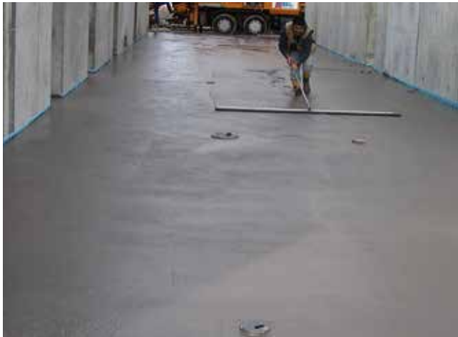
Świeży beton w terminalu lotniczym.
