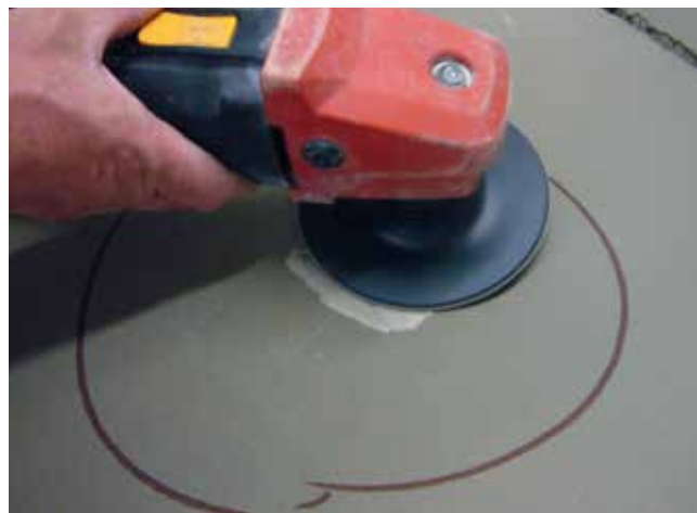
Zeszlifowanie krawędzi punktu pomiaru, łagodne sfazowanie.
