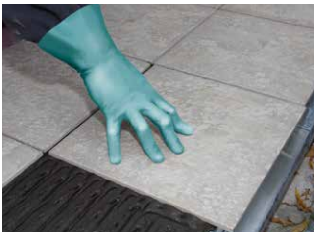
12 Układanie płyt na przygotowanej zaprawie klejowej.
