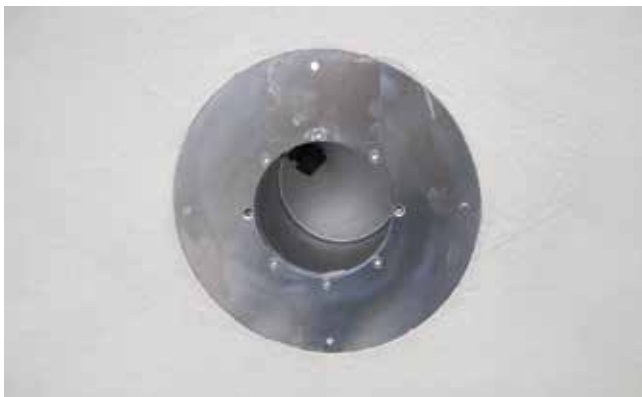
1 Powierzchnia kołnierza powinna być pozbawiona olejów i zatluszczeń.
