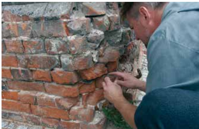
Analiza stanu technicznego muru.
