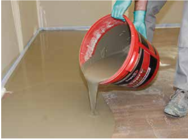
7 Szpachlowanie nierówności za pomocą szpachli samopoziomującej Sopro FAS 551 .
