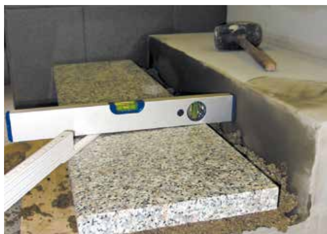
6 Gotowy stopień, ułożony na zaprawie drenażowej Sopro DM 610 .
