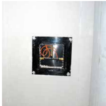
Armatura pod tynkiem z ramką uszczelniającą ...
