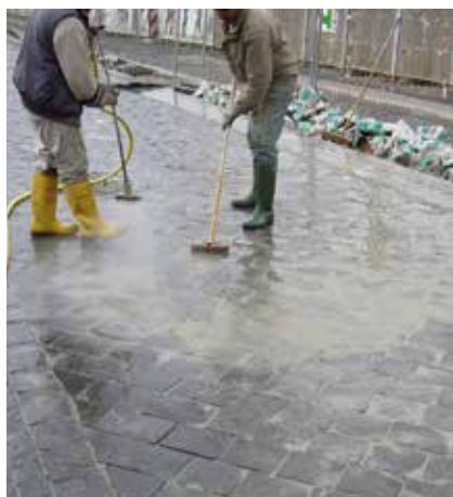
Czyszczenie rozproszonym strumieniem wody.
