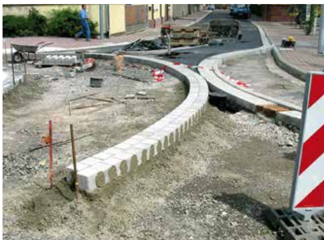
Kostki betonowe, tworzące kanał odwadniający, układane na betonowej warstwie nośnej.
