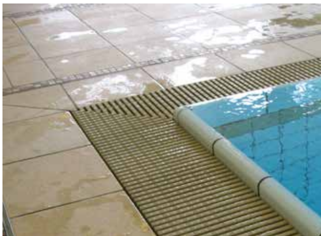
Wysokie lustro wody przy rynnie przelewowej w systemie „Wiesbaden”, które znajduje się ok. 3-4 cm powyżej poziomu powierzchni okołobasenowej.
