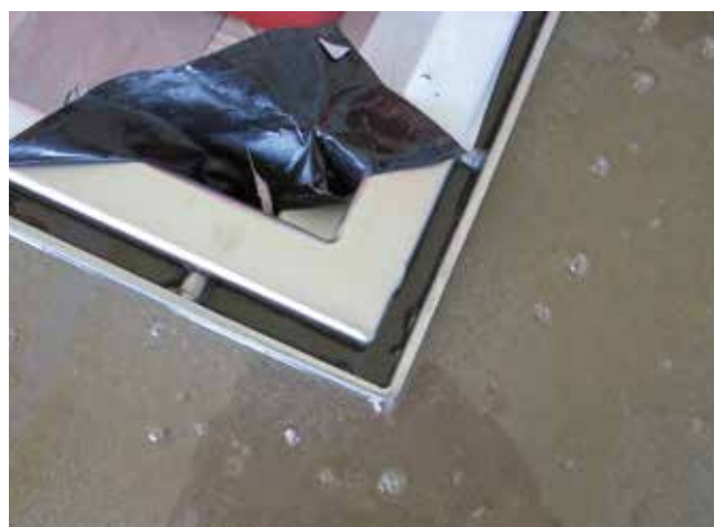
Obramowanie ze stali nierdzewnej jest dobrze widoczne. Mocowania są później zerwane, korpus odwodnienia może swobodnie się przemieszczać.
