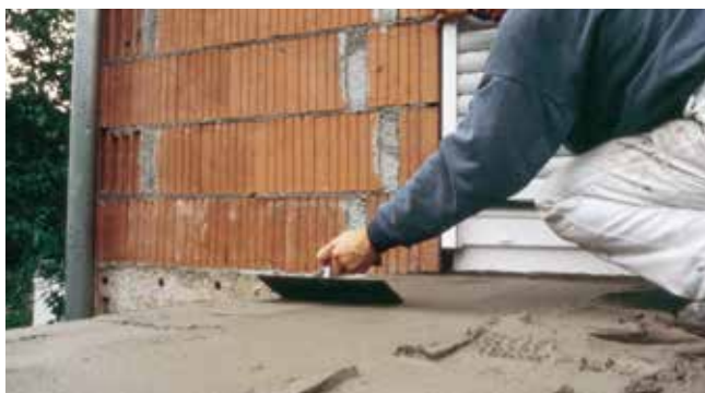
Wykonanie powierzchni spadkowej na balkonowej płycie wspornikowej, przy pomocy szpachli wyrównawczej Sopro RAM 3® lub Sopro AMT 468 .
