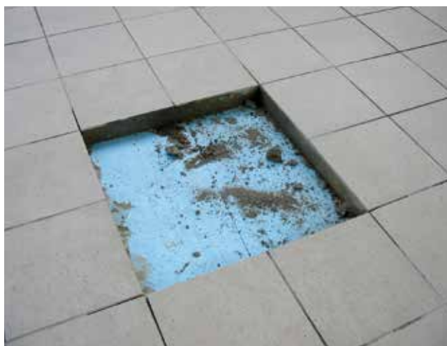
Jastrych na warstwie izolacji termicznej.
