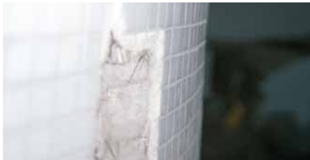
Deformacja okładziny.
