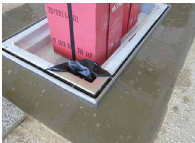
Uszczelnienie kapilarne odwodnienia wykonane mieszanką epoksydowo-piaskową ( Sopro EPG 522 zmieszane w proporcji 1:1:1 z Sopro QS 507 i Sopro QS 511 ). Odpływ poprzez zastosowanie obciążnika jest zabezpieczony przed przemieszczeniem.
