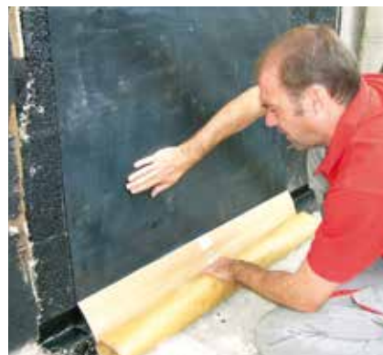
12 Przygotowany odcinek taśmy przykleić i docisnąć do powierzchni ściany.
