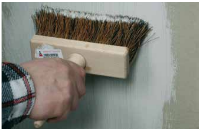
Nanoszenie mineralnych izolacji szlamowych.
