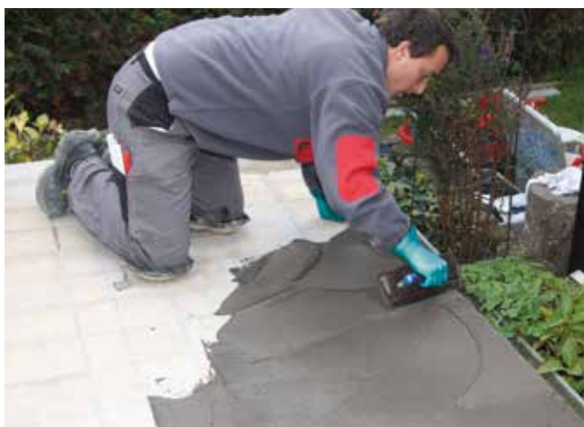
3 Nałożenie wysokoelastycznej zaprawy klejowej Sopro MEG 666 pod następnie układane maty uszczelniająco-odcinające Sopro AEB® 639 plus .
