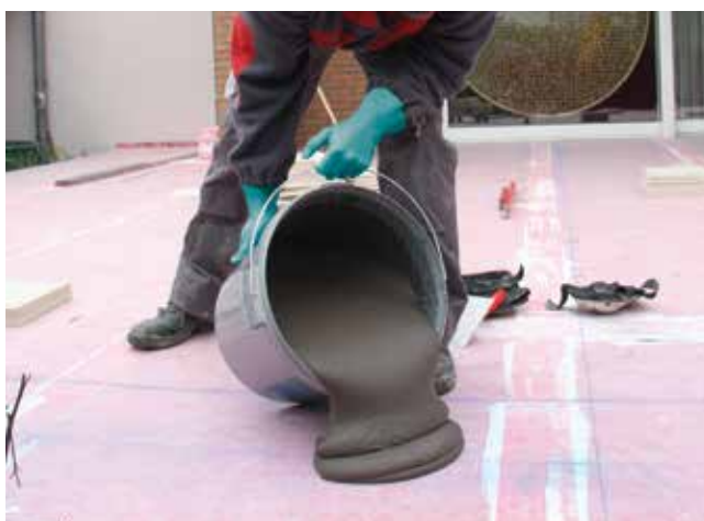
10 Wylanie cienkowarstwowej zaprawy klejowej Sopro MEG 666 , przygotowanej w konsystencji półpłynnej.
