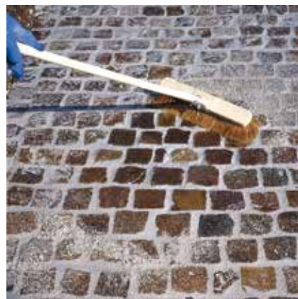
Czyszczenie zaspoinowanej okładziny.
