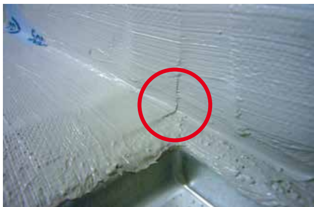
Taśma zatopiona w uszczelnieniu – szczelność połączenia.
