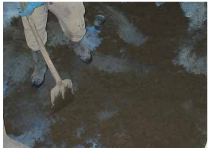
Tworzenie jastrychu zespolonego; nakładanie zaprawy jastrychowej na świeży mostek szepny.
