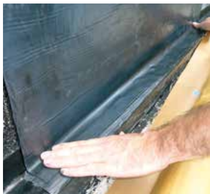
13 Usunąć całkowicie papier zabezpieczający i w obszarze styku samoprzylepną izolację bitumiczną SoproThene® 878 nakleić na zakładkę na wcześniej przyklejonej taśmie SoproThene® 87808 na fundamencie.
