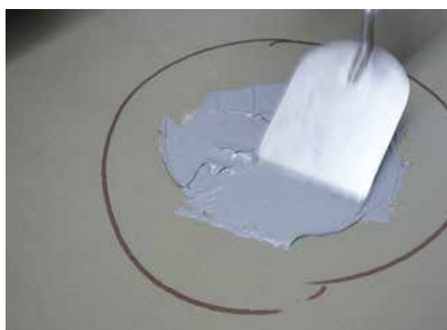
Wypełnienie wycięcia uszczelnieniem zespolonym.
