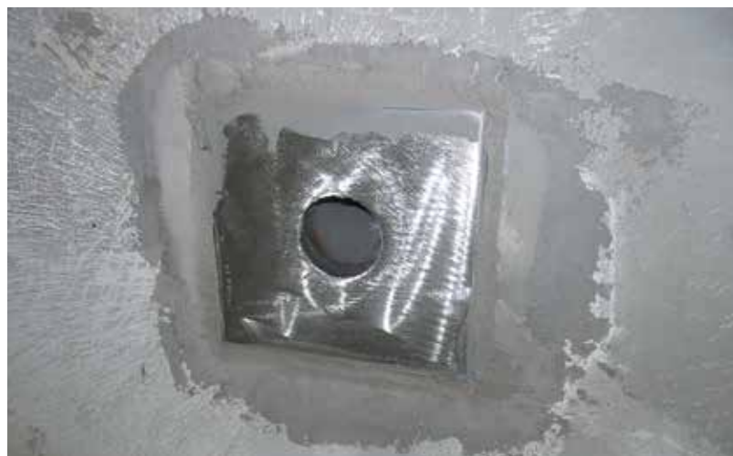
Kołnierz z tuleją, osadzony w niecce basenowej przy użyciu zaprawy epoksydowej.
