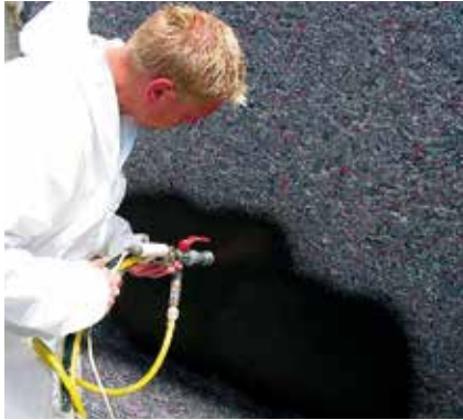
16 Natrysk bitumicznej masy uszczelniającej Sopro KSP 652 przy pomocy pompy Inomat.
