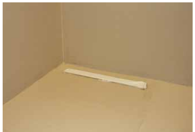
6 Naroże prysznicowe uszczelnione Sopro DSF® 523 w 2-ch warstwach (obszar ścian i posadzki) pod układane płytki.
