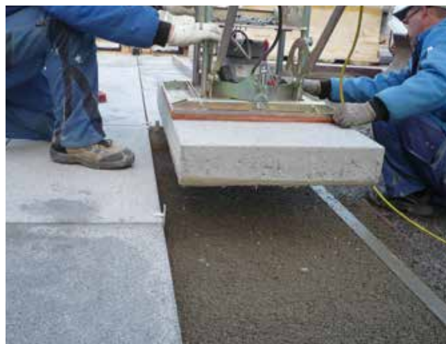
Obecnie dla wykonania nawierzchni obok płyt z kamienia naturalnego stosuje się również wielkoformatowe płyty betonowe.
