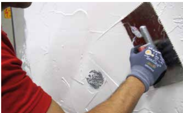
3 Obróbka całej powierzchni z użyciem uszczelnienia zespolonego.
