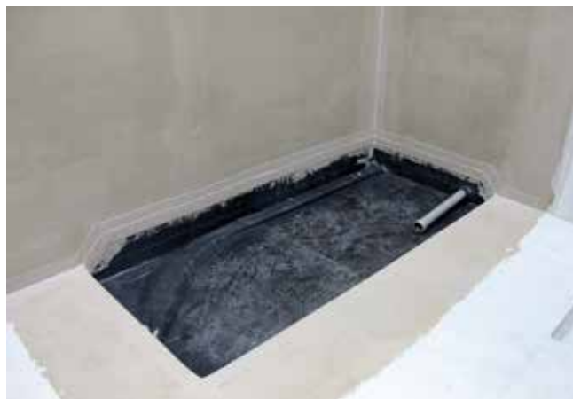
6 Dokładnie uszczelniona powierzchnia dla montażu i podłączenia wanny.
