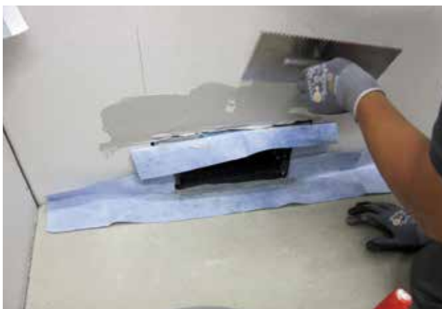
5 Montaż uszczelki do podłoża na zaprawie Sopro DSF® 523 .
