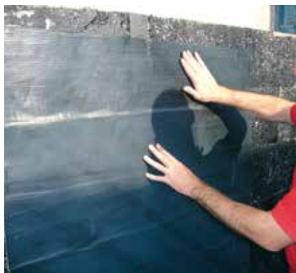
10 Izolację bitumiczną SoproThene® 878 wyrównać i docisnąć do podłoża.
