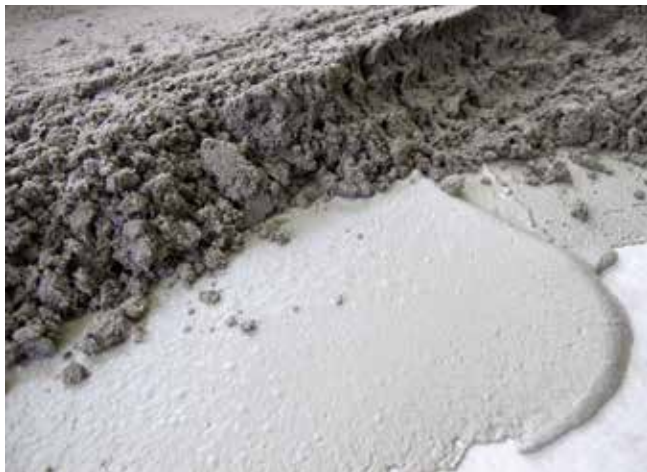
Świeży jastrych nałożony na świeżą warstwę podkładu Sopro HSF 748 tzw. metodą „mokre na mokre”.
