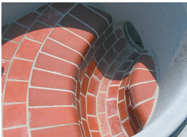
Spoinowanie odporne na fekalia i siarczany w obszarach kanalizacyjnych i w pomieszczeniach przeznaczonych do hodowli zwierząt.
