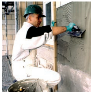
Metoda kombinowana – nałożenie warstwy kontaktowej i grzebieniowej na podłożu
