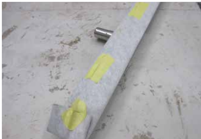
1 Odwodnienie liniowe posiada fabrycznie zamontowany kołnierz uszczelniający.
