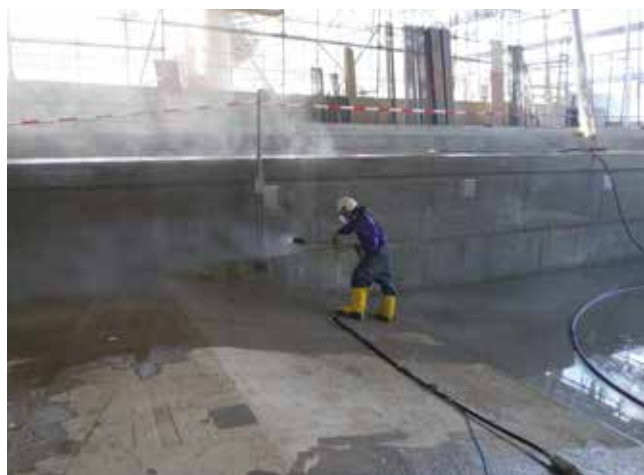
Czyszczenie powierzchni betonowej metodą piaskowania lub strumieniem wody pod ciśnieniem.
