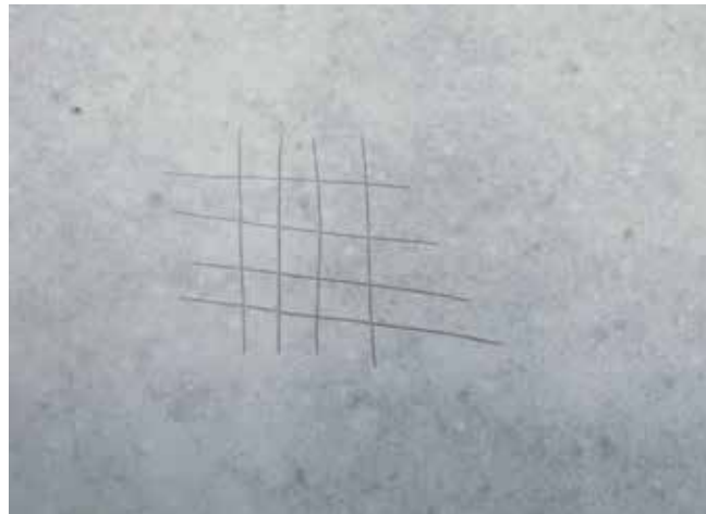
Po zeszlifowaniu widoczne są tylko ostre zarysowania. Powierzchnia optymalnie została przygotowana do układania.
