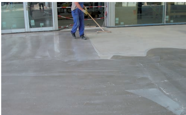
Aplikacja preparatu Sopro EPG 522 w celu zabezpieczenia jastrychu anhydrytowego przed przenikaniem wilgoci.
