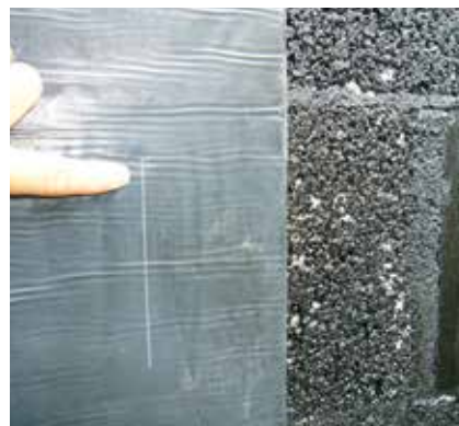
15 Zaznaczenie miejsca zakładu dla następnego odcinka samoprzylepnej izolacji bitumicznej SoproThene® 878 ułatwia pracę.
