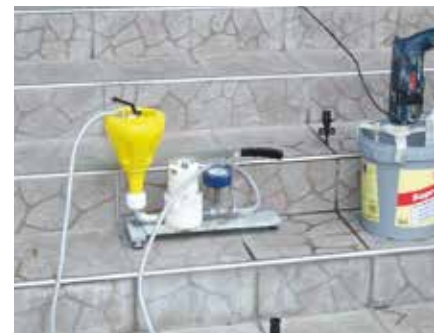
Wypełnianie pustek pod okładziną na schodach.
