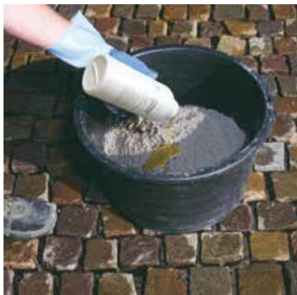
Dozowanie utwardzacza do mieszanki piaskowo-żywiczej.
