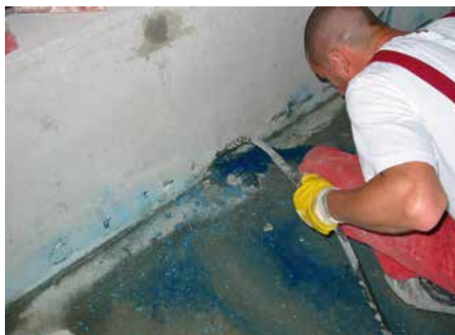
Wypełnianie rys w niecce z betonu wodoszczelnego.
