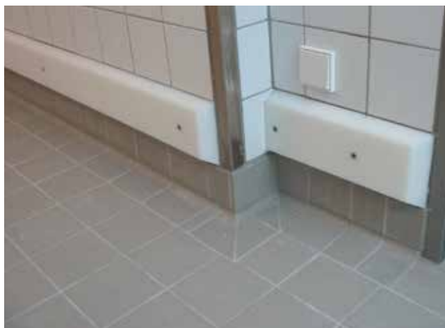
Wykonany element cokołu z ochroną odbojową.
