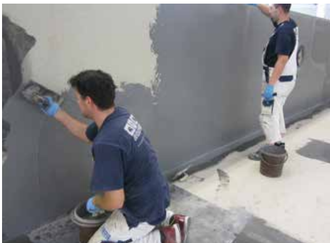
Uszczelnienie zespolone ( Sopro DSF® 523 ) nakładane metodą szpachlowania.
