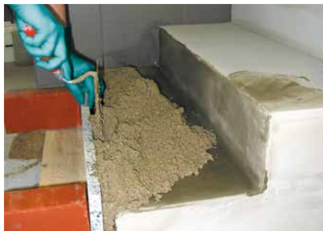
4 Osadzenie podstopnicy na zaprawie drenażowej Sopro DM 610 .
