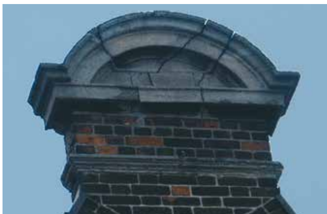
Wpływ działania czynników atmosferycznych na niezabezpieczone, wykończenie betonowe murów.
