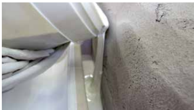
Wypełnienie antykapilarne elastycznym materiałem Sopro ( Sopro PU-FD ).
