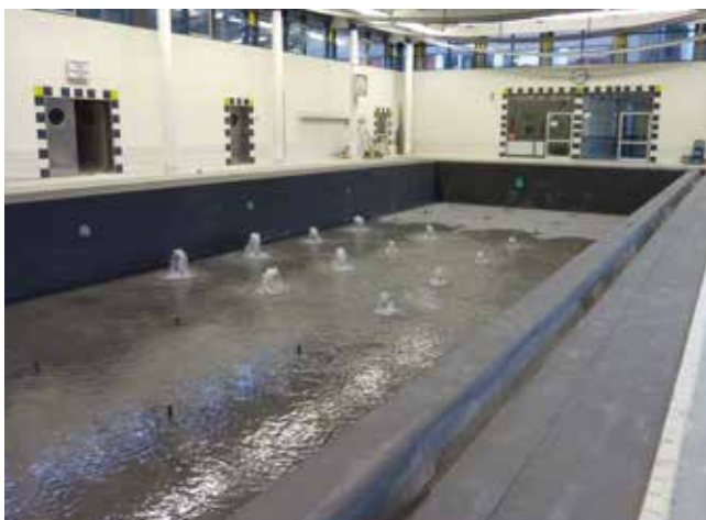
Po naniesieniu i wyschnięciu uszczelnienia zespolonego w niecce basenowej przeprowadza się próbę wodną.
