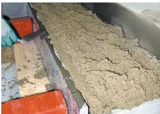
5 Warstwa zaprawy drenażowej przygotowana do osadzenia stopnicy.
