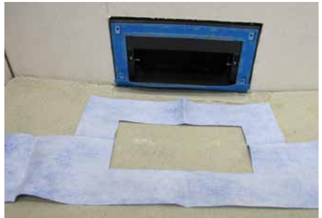
4 Uszczelka (z klejem) do połączenia odpływu ściennego z uszczelnianą powierzchnią ( Sopro DSF® 523 ).
