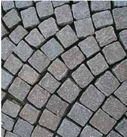
Kostka z kamienia naturalnego o różnych szerokościach spoin, do wypełnienia za pomocą wysokowytrzymałej zaprawy do fugowania kostki brukowej Sopro PFM .
