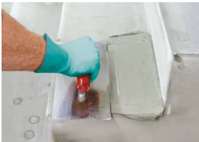
1 Wyprowadzenie spadku na stopniach przy pomocy szpachli Sopro RAM 3® lub Sopro AMT 468 .
