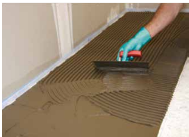
15 Na płyty izolacyjne Sopro FDP 558 do układania okładziny ceramicznej nałożyć zaprawę klejową Sopro VF XL 413 .
