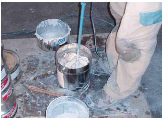
3 Dokładne wymieszanie składników A i B elastycznej powłoki uszczelniającej Sopro PU-FD po przełożeniu do nowego pojemnika.
