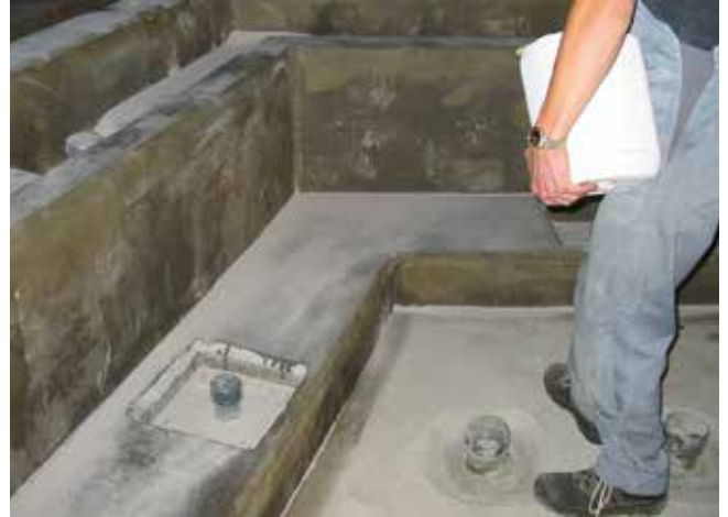
2 Wykonywanie posypki z piasku kwarcowego Sopro QS na świeżej warstwie preparatu epoksydowego Sopro EPG 522 .
