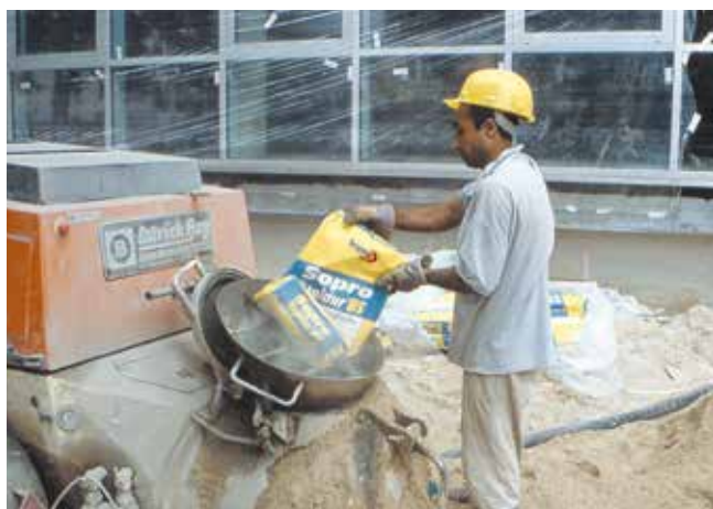
Łatwa obróbka spoiwa szybkowiążącego Sopro Rapidur® B5 poprzez dozowanie w trakcie mieszania na miejscu budowy.
