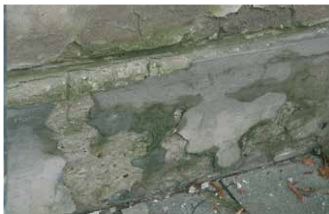
Próba naprawy powierzchni tynku wapiennego zaprawami cementowymi.
