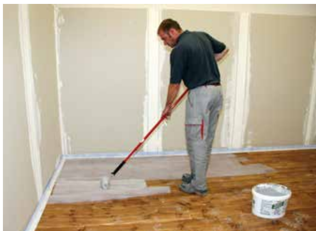
6 Na powierzchnię podłogi drewnianej nanieść preparat gruntujący do podłoży niechłonnych Sopro HPS 673 .
