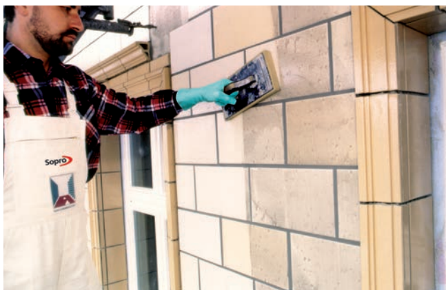
Zmywanie zaszlamowanej powierzchni.
