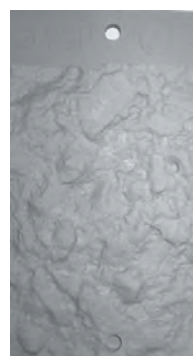
CSP-10 Ręczne śrutowanie a następnie obróbka strumieniowo-ścierna
