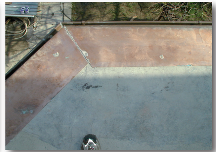
3. Obróbki blacharskie odłuszczone i gruntujemy materiałem Sika®-Primer 3
