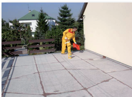
1. Przed aplikacją materiału konieczne jest suche i równe podłoże. W przypadku zastosowania na podłożu nienasiąkliwym np.: lastrico, gres, płytka szkliona stosujemy żywicę gruntującą Sikafloor®-156
