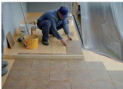
11. Klej aplikujemy tylko na podłoże
