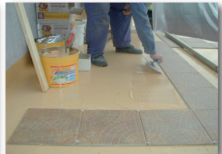
9. Po utwardzeniu materiału (min. 20 godzin) nakładamy warstwę klejącą pacą grzebienią
