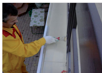
4. Sikafloor®-400 N Elastic+ wyprowadzamy na obróbkę blacharską i balustradę
