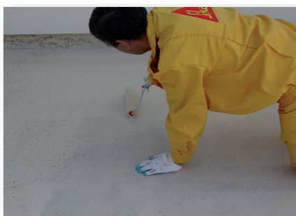
5. Można dekoracyjnie posypać powierzchnię płatkami lub piaskiem kwarcowym. Na koniec wykonujemy warstwę zamykającą produktem Sikafloor® 410
