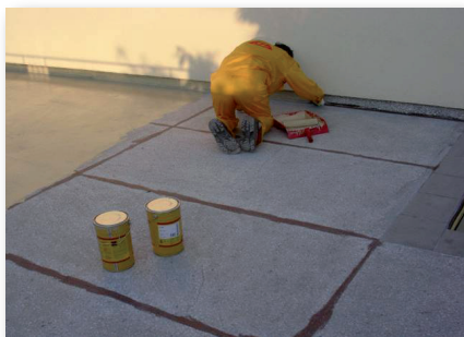
3. Oznaczamy górną krawędź cokołu, aby zniwelować kąt pomiędzy przejściem pionu z poziomem aplikujemy Sikaflex®-11 FC
