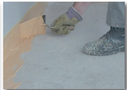
6. Izolujemy materiałem SikaBond®-T8 przejście pionu z poziomem
