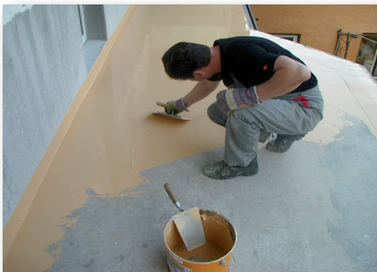
7. Pacą gładką aplikujemy materiał na podłoże
