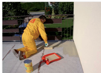
2. Sikafloor®-400 N Elastic+ aplikujemy wałkiem odpornym chemicznie z krótkim włosiem w dwóch warstwach
