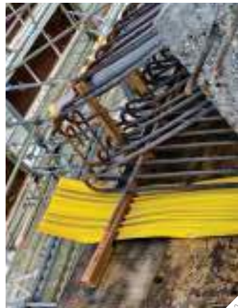
Technologia „białej wanny” Sika White Box / Beton wodoszczelny Sika® Watertight Concrete
