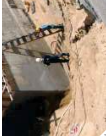
Powłoki wykonywane z płynnych systemów żywic reaktywnych (PUR/PUA)
