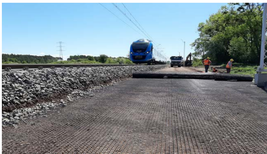
📍 Szamotuły, Polska 📄 Modernizacja linii kolejowej LKE59 Rokietnica-Wronki w okolicach miasta Szamotuły 🔲 Polgrid BX 40/40 8760 m 2
