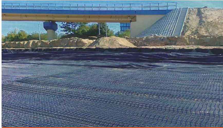
📍 Warszawa (woj. Mazowieckie) 📄 Droga ekspresowa S2 🧺 Polgrid BX 30/30 oraz geotkanina separacyjna 50.000 m 2
