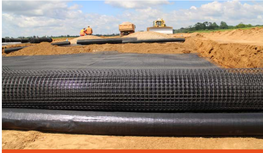
📍 Płock (woj. mazowieckie) 📄 Budowa trasy północno-zachodniej miasta Płock 🔲 PolGrid BX30/30 ilość 82 000m 2
