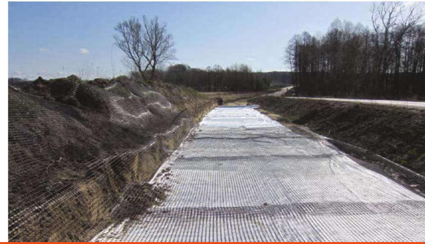
📍 Srokowo (woj. warmińsko-mazurskie) 📄 Budowa drogi wojewódzkiej DW650 🔲 Polgrid BX 30/30 oraz geotkanina 30.000 m 2
