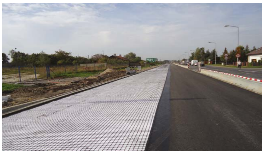
📍 Kalisz (woj. wielkopolskie) 📄 Przebudowa ul. Wrocławskiej, wzmacnianie warstw bitumicznych 🔲 Polgrid FSR BX 20/20 150PP 48.000 m 2
