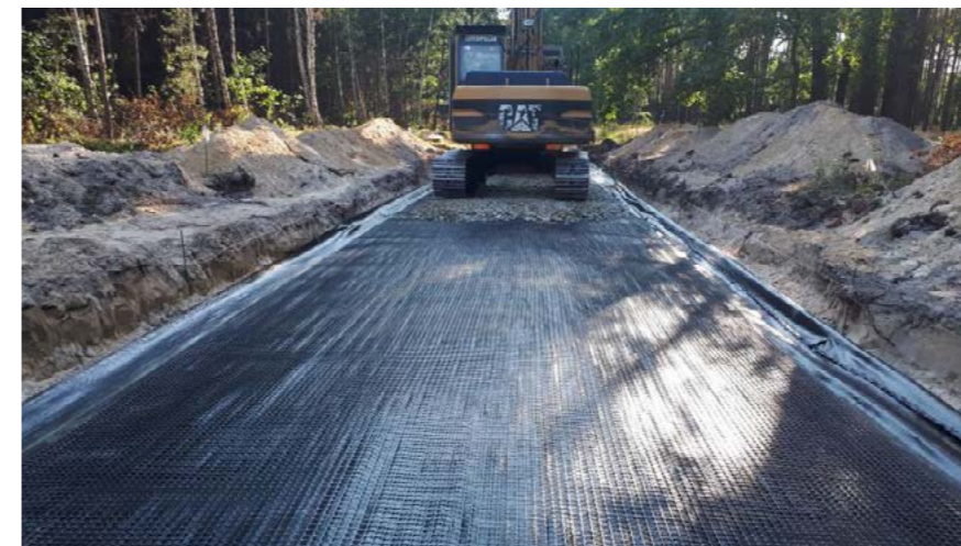
📍 Góra Śląska (woj. dolnośląskie) 📄 Georuszty PolGrid wykorzystane przy modernizacji drogi leśnej 🔲 Polgrid BX 45/45 16.680 m 2
