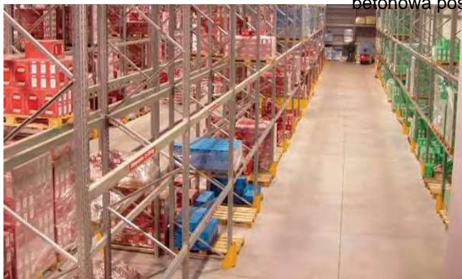
Rys. 6. Magazyn o określonym przez ustawienie regałów ruchu wózków do wysokiego składowania materiałów (fot. autorzy)
