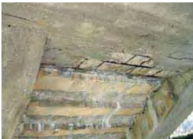
Szkody korozyjne na spodniej stronie konstrukcji schodów, powstałe na skutek braku uszczelnienia i zbyt cienkiego pokrycia zbrojenia betonem.
