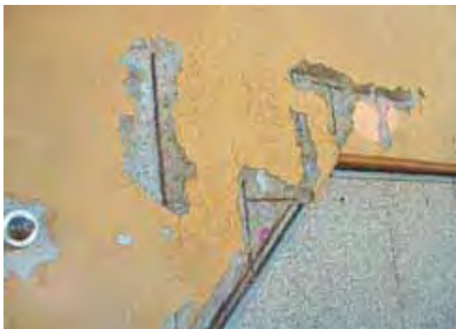
Odpryski fasady betonowej powstałe na skutek pokrycia zbrojenia zbyt cienką warstwą betonu.
